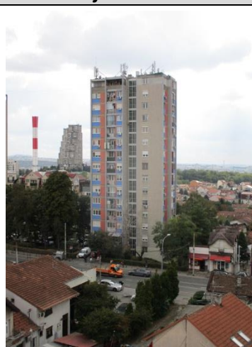
Lokacija bazne stanice
