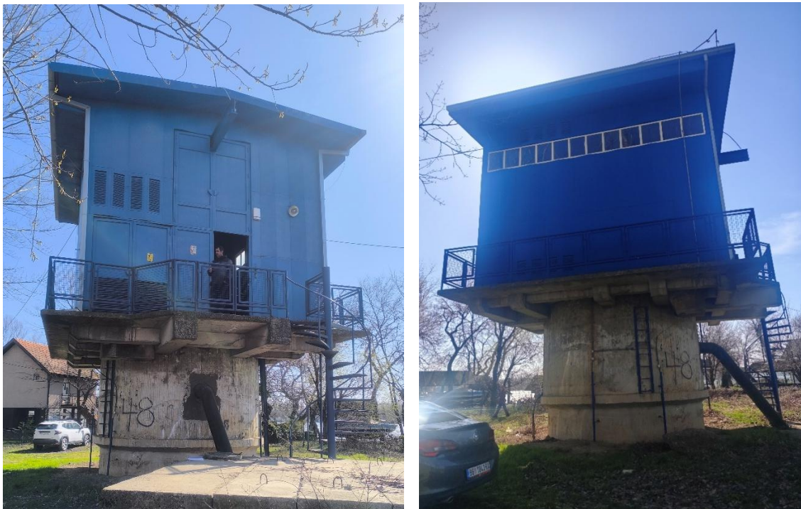
Слика 2. Надземни део бунара РБ-48 – машинска сала и затварачница
