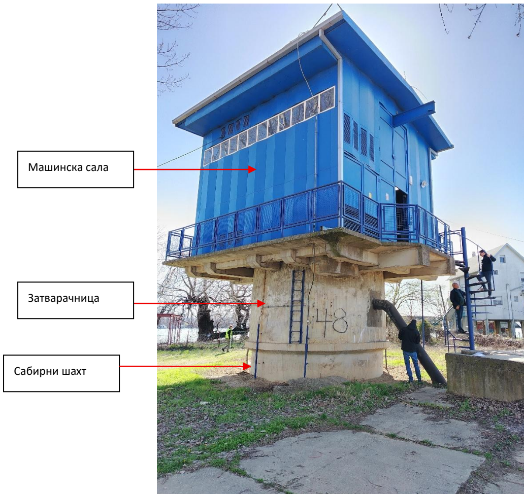
Слика 4 – Надземни део бунара РБ-48 - машинска сала и затварачница (приказ споља, март 2026.)
