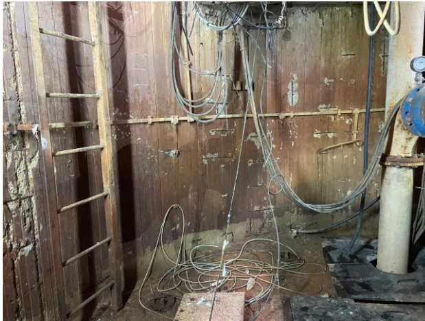
Сл.1.5.1.5.6/7. Изглед унутрашњег простора затварачнице- корозија на зидовима, гредама, на металним деловима- пењалице, поклопци, цевовод
