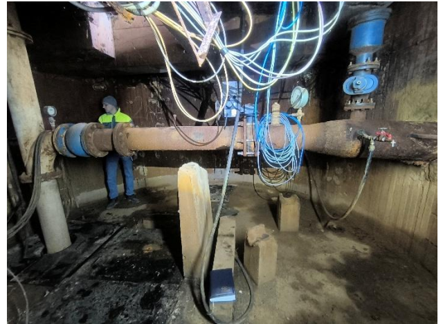
Сл.1.5.1.5.6/7. Изглед унутрашњег простора затварачнице- корозија на зидовима, гредама, на металним деловима- пењалице, поклопци, цевовод
