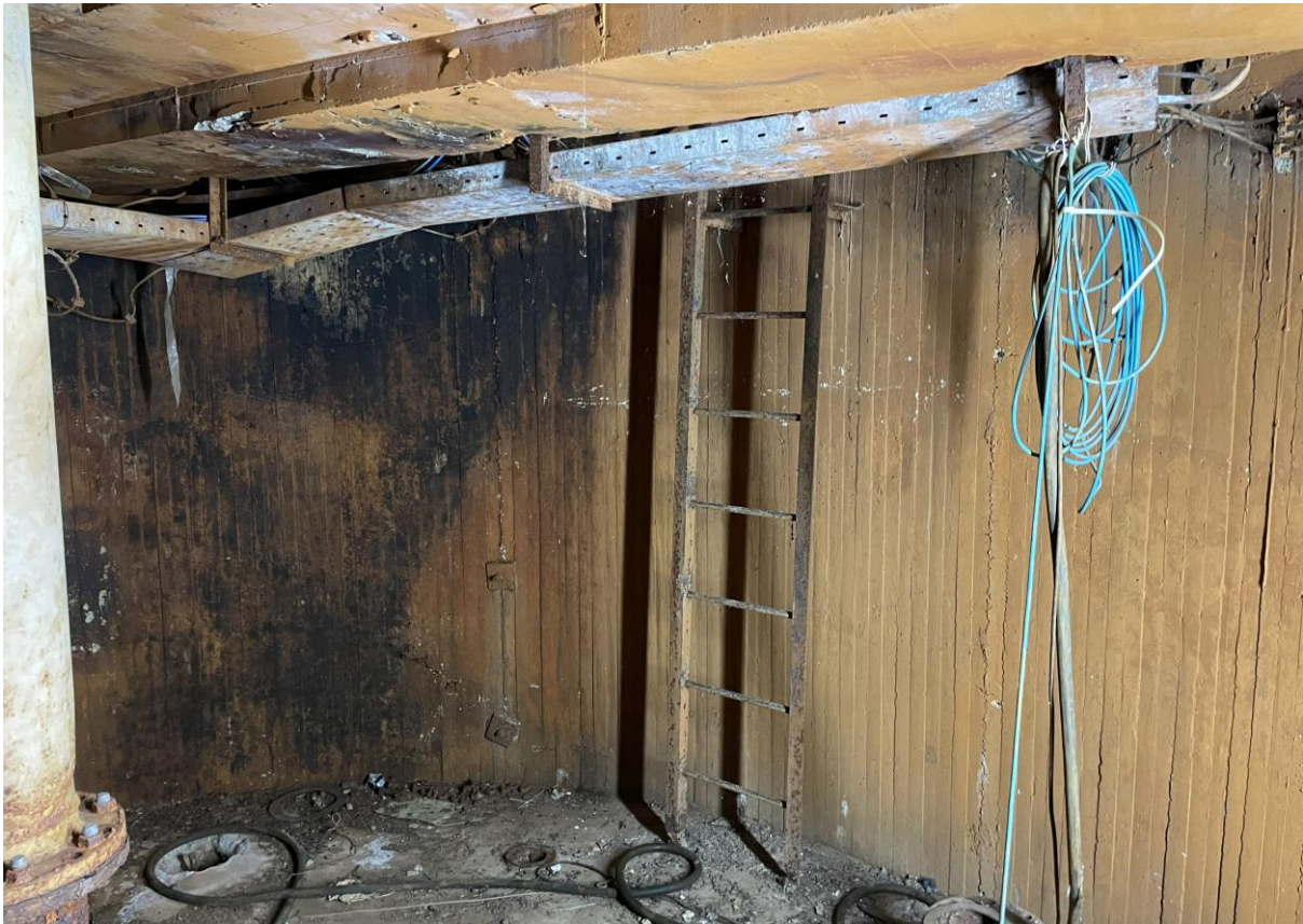
Сл.1.5.1.5.9. Изглед затварачнице- на зидовима, гредама, пењалицама, ел. регалима корозија
