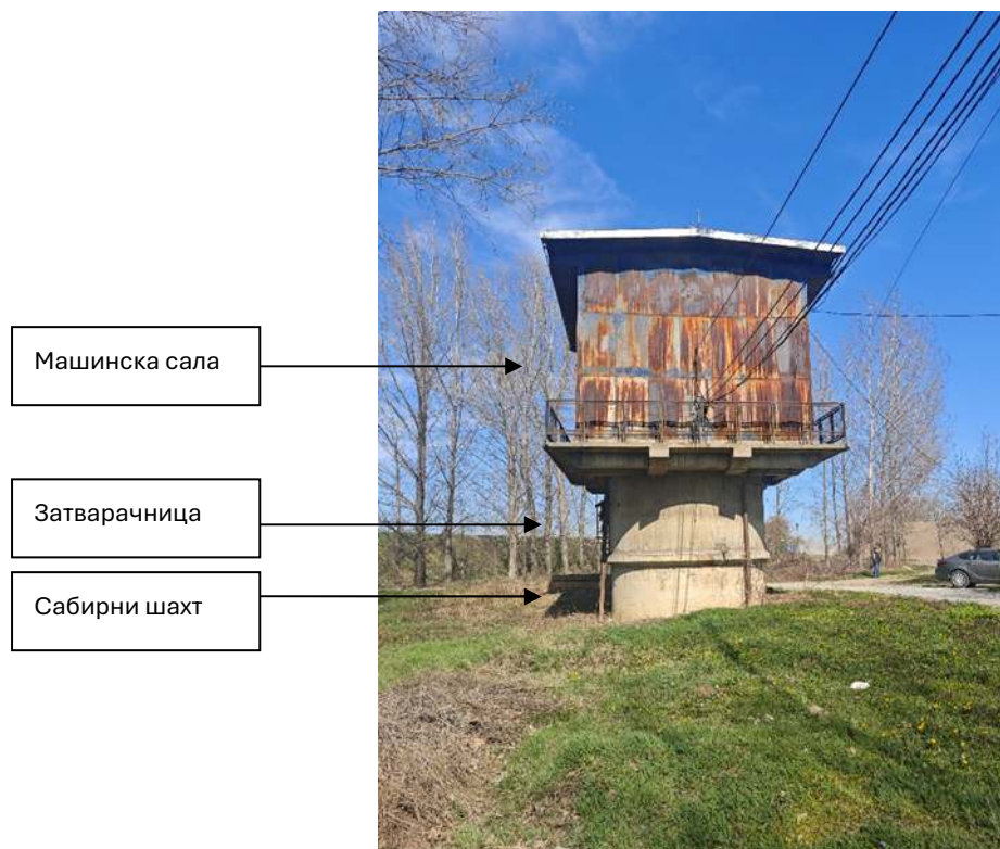
Слика 4 – Надземни део бунара РБ-47 - машинска сала и затварачница (снимак 2026 год.)
