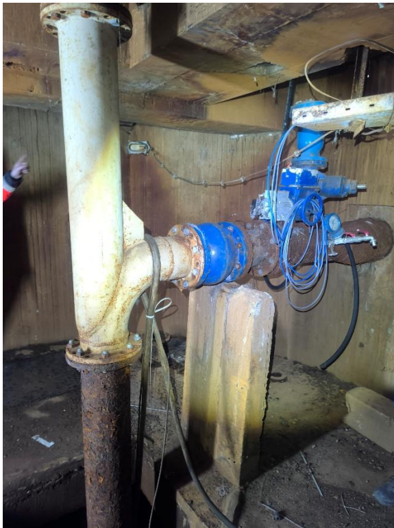
Сл.1.5.1.5.11/12. Изглед затварачнице-корозија на металним деловима, електро носачима
