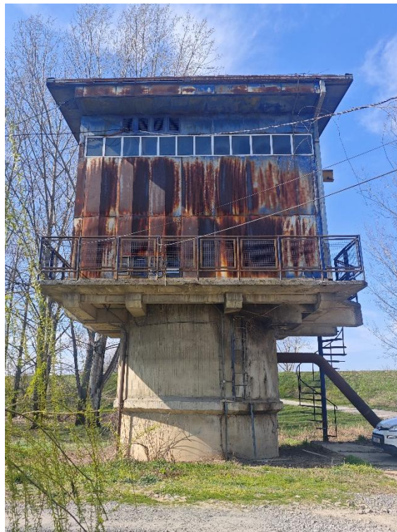
Слика 2. Надземни део бунара РБ-47 – машинска сала и затварачница
