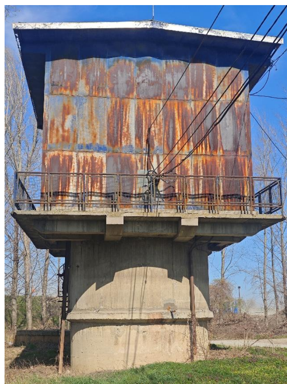
Сл.1.5.1.5.5. Изглед задње стране
