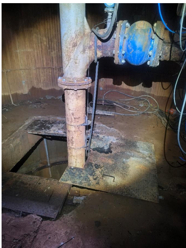
Сл.1.5.1.5.8/9. Изглед унутрашњег простора затварајнице- корозија на зидовима, поду, на металним деловима- пењалице, поклопци, цевовод
