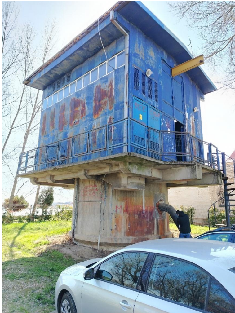
Слика 2. Надземни део бунара РБ-49 – машинска сала и затварачница
