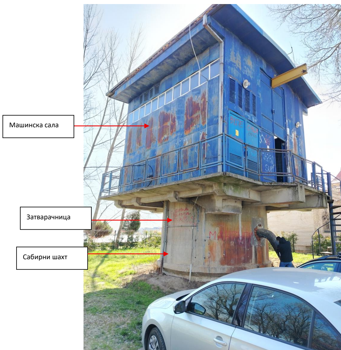
Слика 4 – Надземни део бунара РБ-49 - машинска сала и затварачница (приказ споља, март 2026.)
