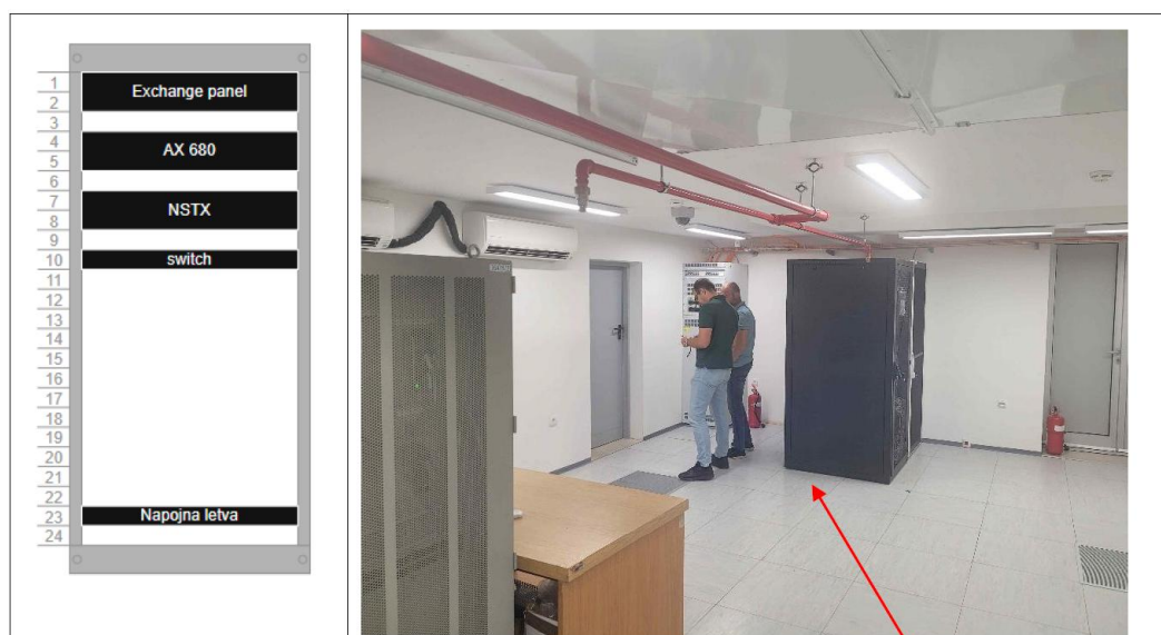
Slika 2.4 Kabinet MLAT radio stanice i pozicija montaže
