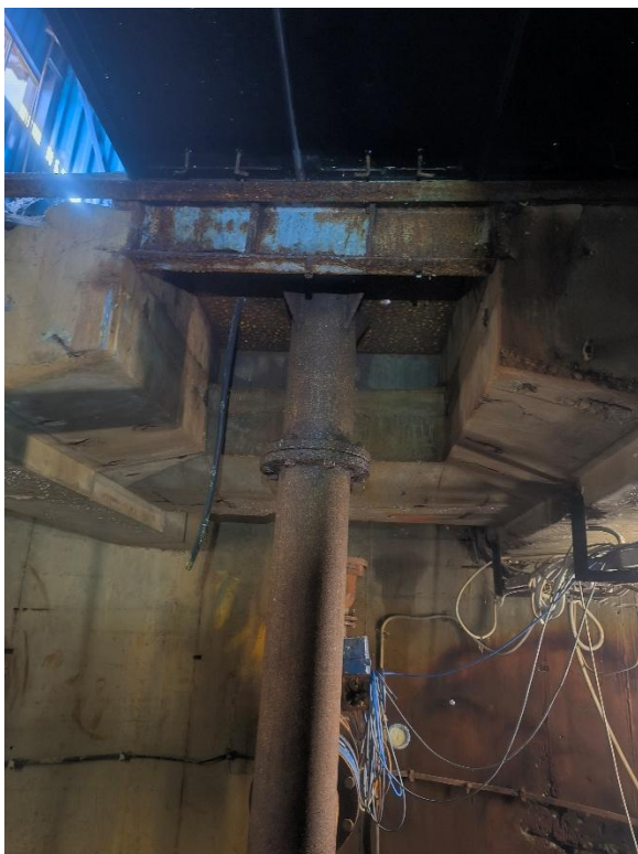
Сл.1.5.1.5.10/11. Изглед затварачнице-корозија на металним деловима, електро носачима
