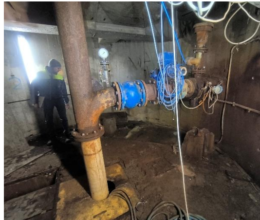
Сл.1.5.1.5.8/9. Изглед затварачнице- корозија на металним поклопцима, поду, потисним цевоводом
