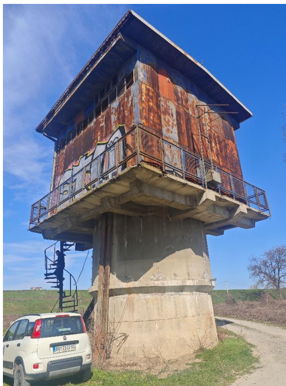
Сл.1.5.1.5.5. Изглед задње стране
