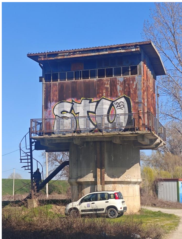
Сл.1.5.1.5.2. Изглед бунара са бочне стране
