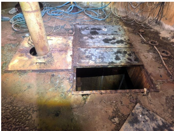
Сл.1.5.1.5.8/9. Изглед затварачнице- корозија на металним поклопцима, поду, потисним цевоводом
