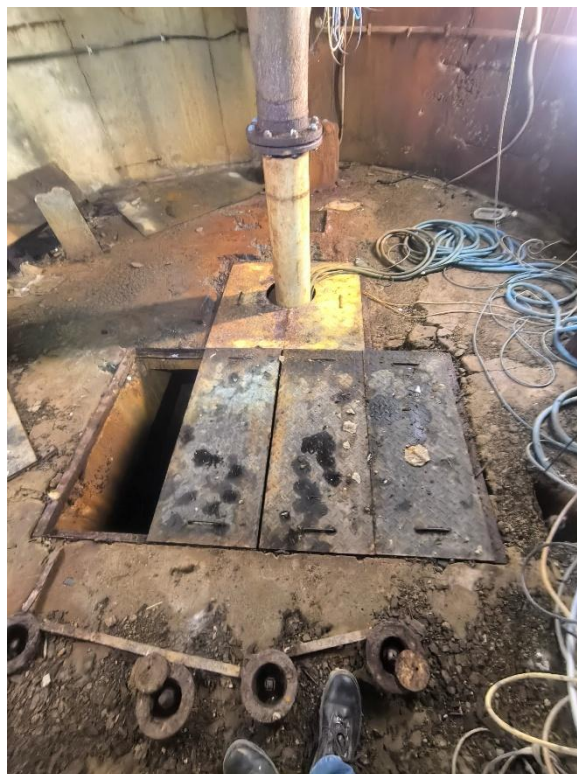
Сл.1.5.1.5.10/11. Изглед затварачнице-корозија на металним деловима, електро носачима
