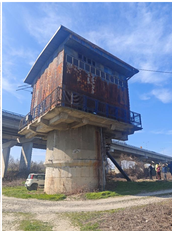
Сл.1.5.1.5.3. Изглед бунара са бочне стране
