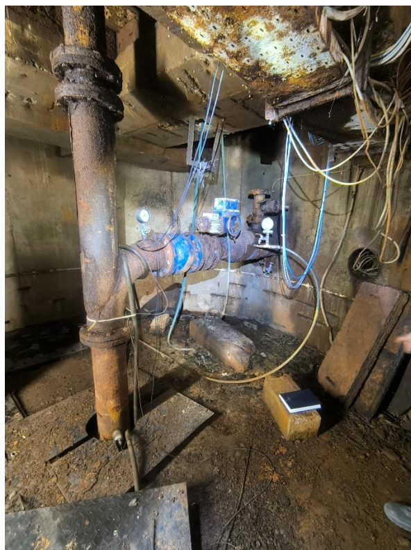
Сл.1.5.1.5.8/9. Изглед унутрашњег простора затварачнице- корозија на зидовима, поду, на металним деловима
