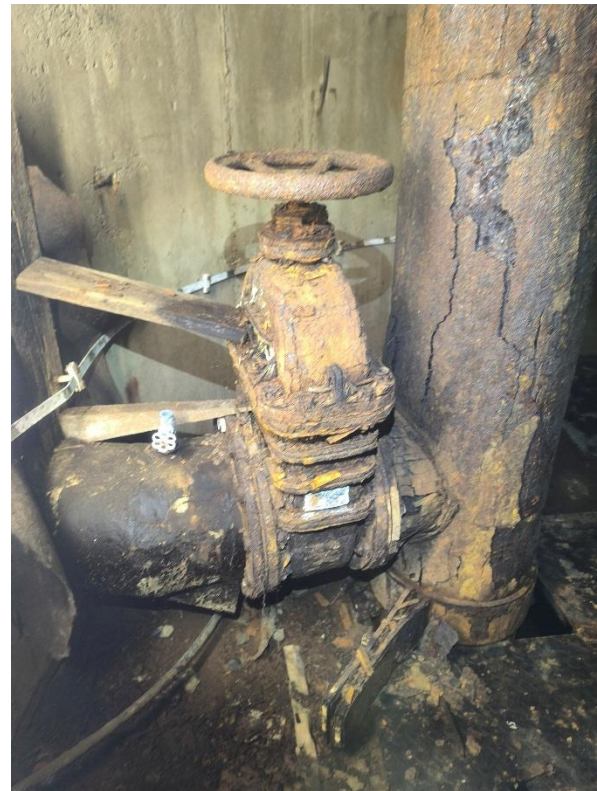
Сл.1.5.1.5.8/9. Изглед унутрашњег простора затварачнице- корозија на зидовима, поду, на металним деловима
