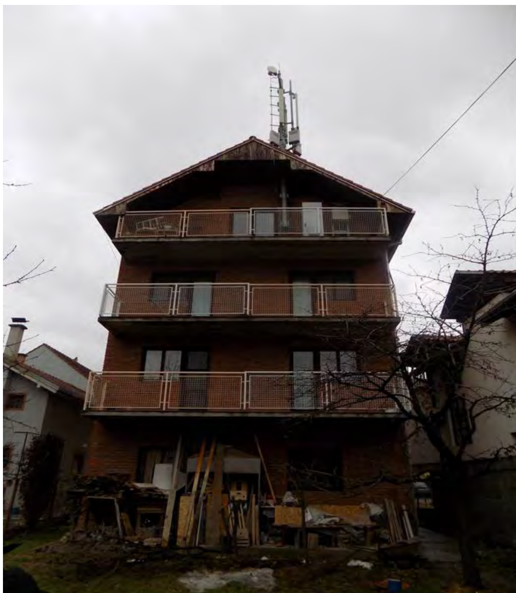
Slika 3.1.1. Fotografija kuće na kojoj je instalirana predmetna bazna stanica
