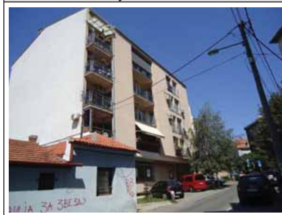
Lokacija bazne stanice
