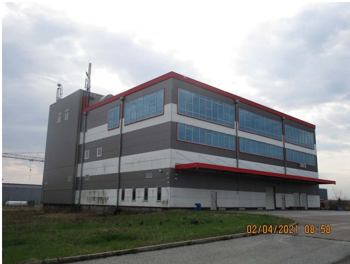
Slika 2.3 Fotografija objekta na kome se planira instalacija nove CETIN BS
