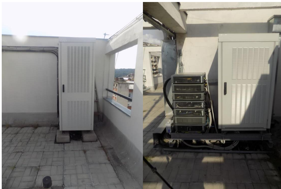
Slika 2.4. Fotografija kabineta predmetne RBS
