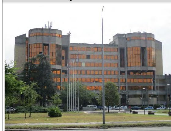
Lokacija bazne stanice
