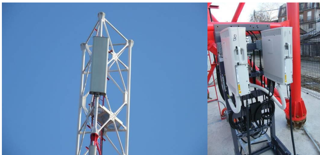
Slika 2.3. Fotografije antenskog sistema i bazne stanice GSM-R na lokaciji
