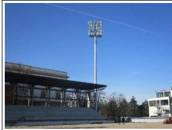
Lokacija buduće bazne stanice
