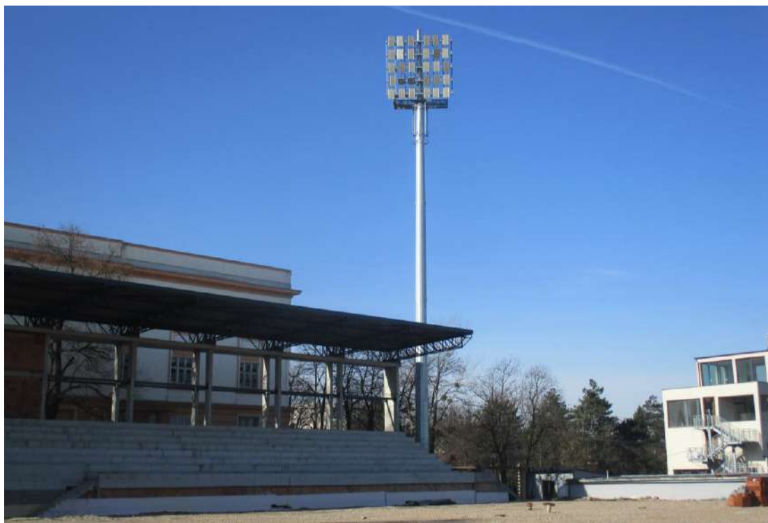
Slika 3.1 – Izgled predmetnog objekta
