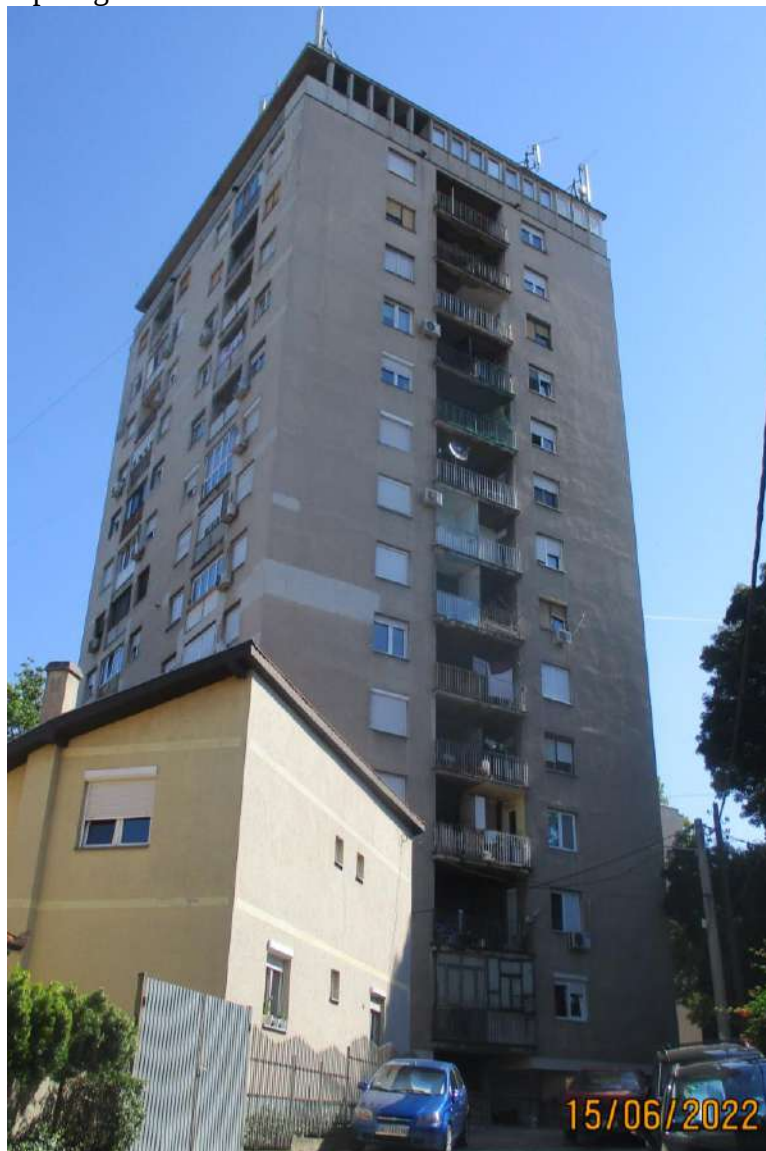
Slika 2.2 Izgled lokacije na kojoj se nalazi instalacija bazne stanice «BG0289_01 BG_Baja Sekulića»
