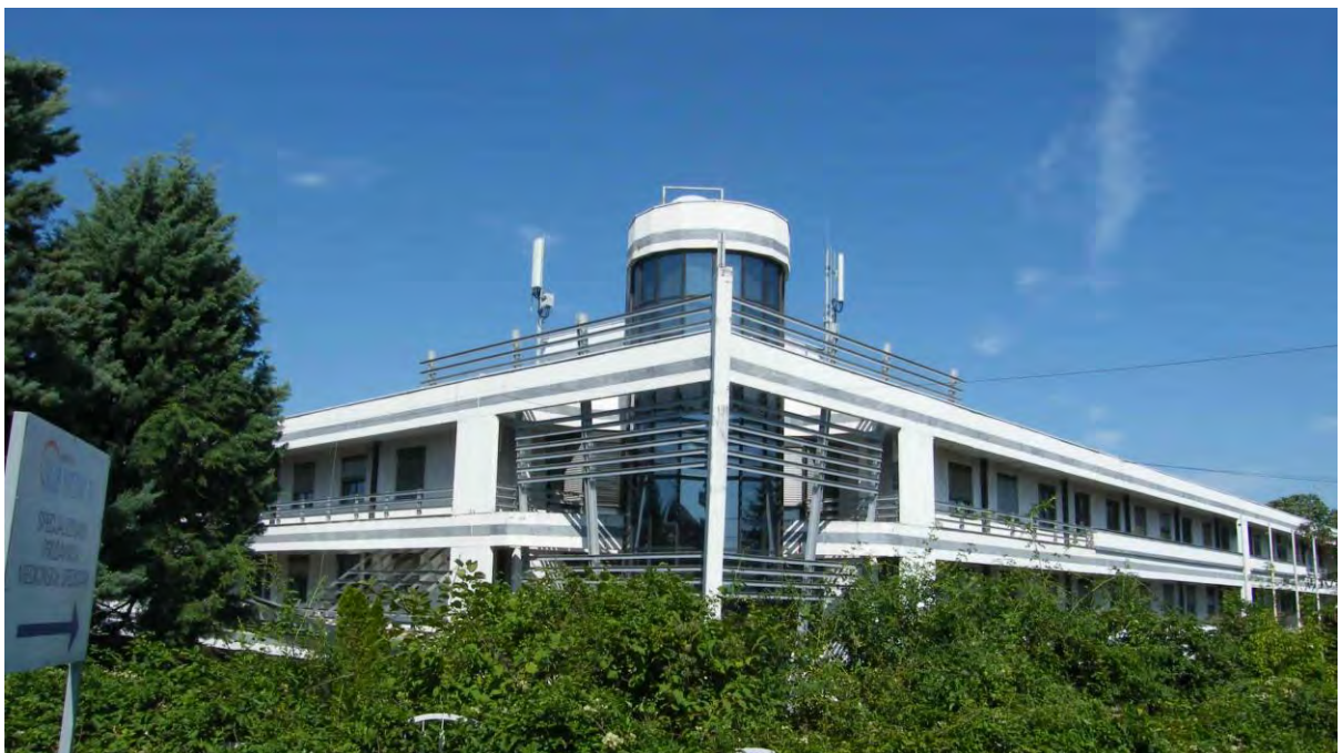
Slika 2.2 Izgled objekta na kom je predviđena bazna stanica BG – Vojvode Stepe (Velefarm)
