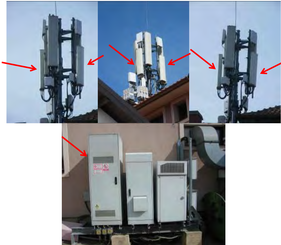
Slika 2.3. Fotografije antenskog sistema i bazne stanice operatera A1 na lokaciji
