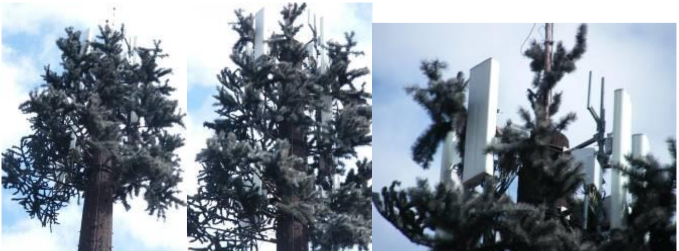
Slika 2.3. Fotografije antenskog sistema i bazne stanice operatera Cetin i A1 na lokaciji
