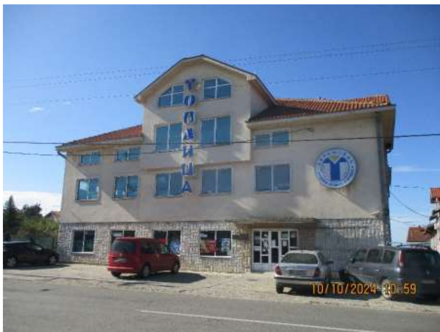
Slika 2.4 Objekat na kome se planira montaža predmetne BS
