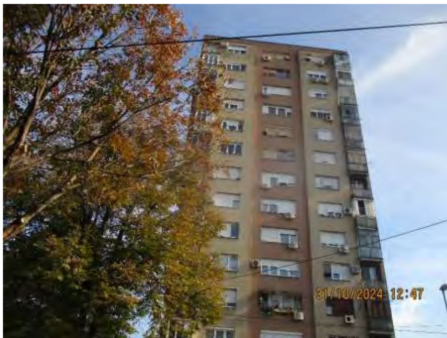
Slika 2.3 Objekat na kome se planira montaža predmetne BS
