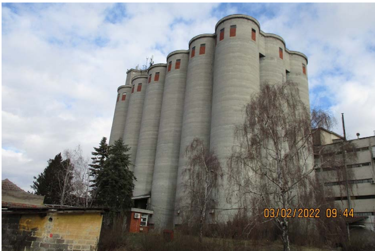
Slika 2.4 Silos na kome se nalazi predmetna BS
