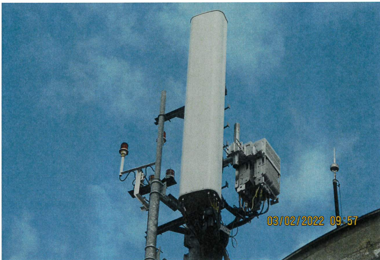
Slika 6: Prikaz antene sektora 2 BS BG_Mladenovac 6 operatora A1 Srbija
