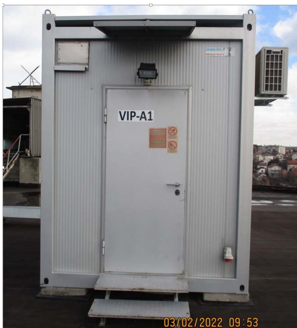
Slika 2.6 Kontejner u kome je smeštena oprema za prenos predmetne BS
