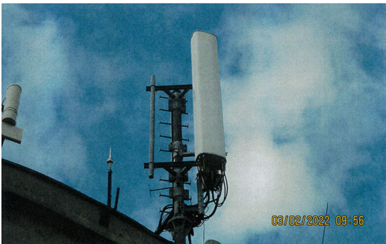
Slika 5: Prikaz antene sektora 1 BS BG_Mladenovac 6 operatora A1 Srbija
