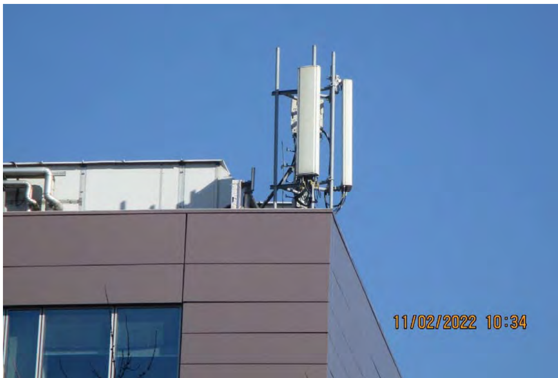
Slika 2.8 Fotografija antene sektora 3 predmetne BS
