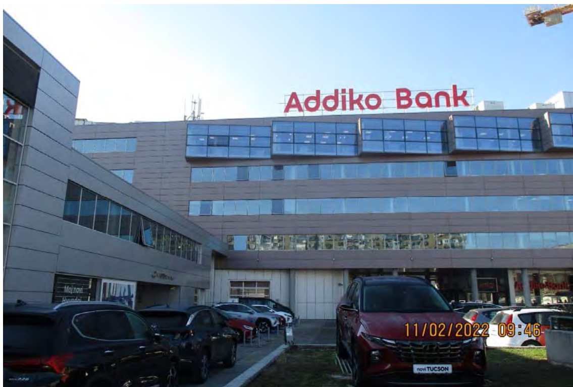
Slika 2.4 Objekat na kome se nalazi predmetna BS
