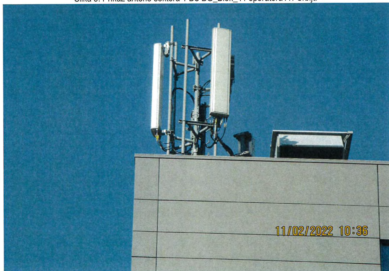
Slika 6: Prikaz antene sektora 2 BS BG_Blok_41 operatora A1 Srbija
