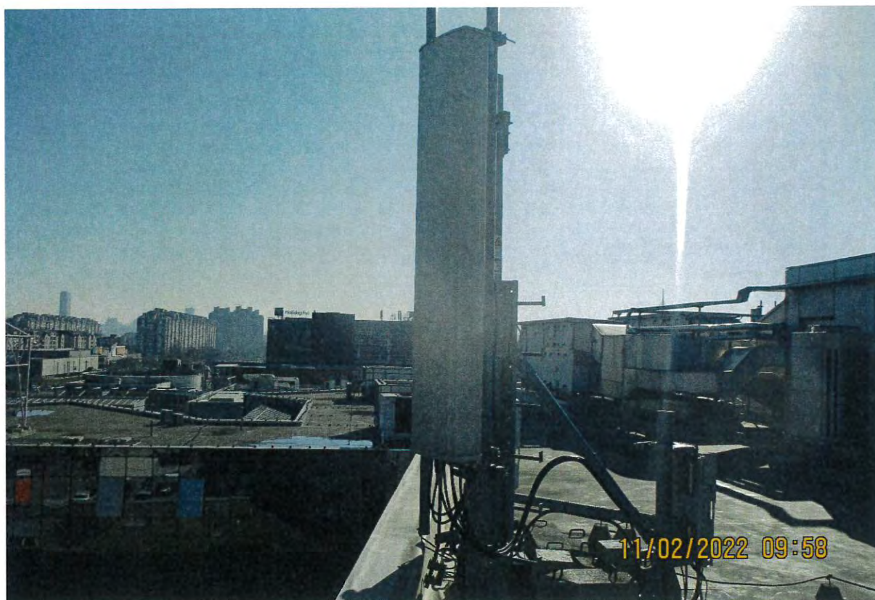
Slika 5: Prikaz antene sektora 1 BS BG_Blok_41 operatora A1 Srbija
