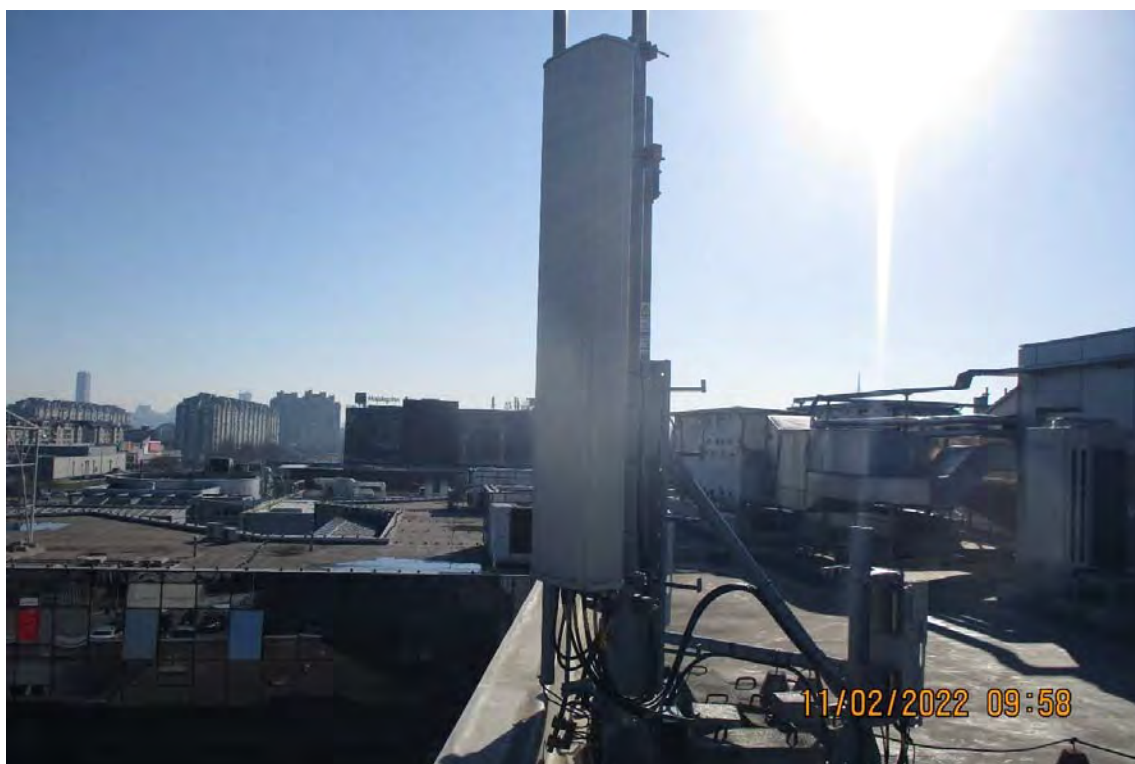
Slika 2.6 Fotografija antene sektora 1 predmetne BS
