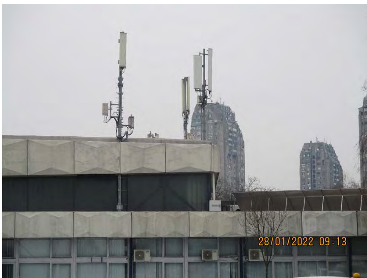
Slika 2.7 Fotografija antene sektora 3 predmetne BS
