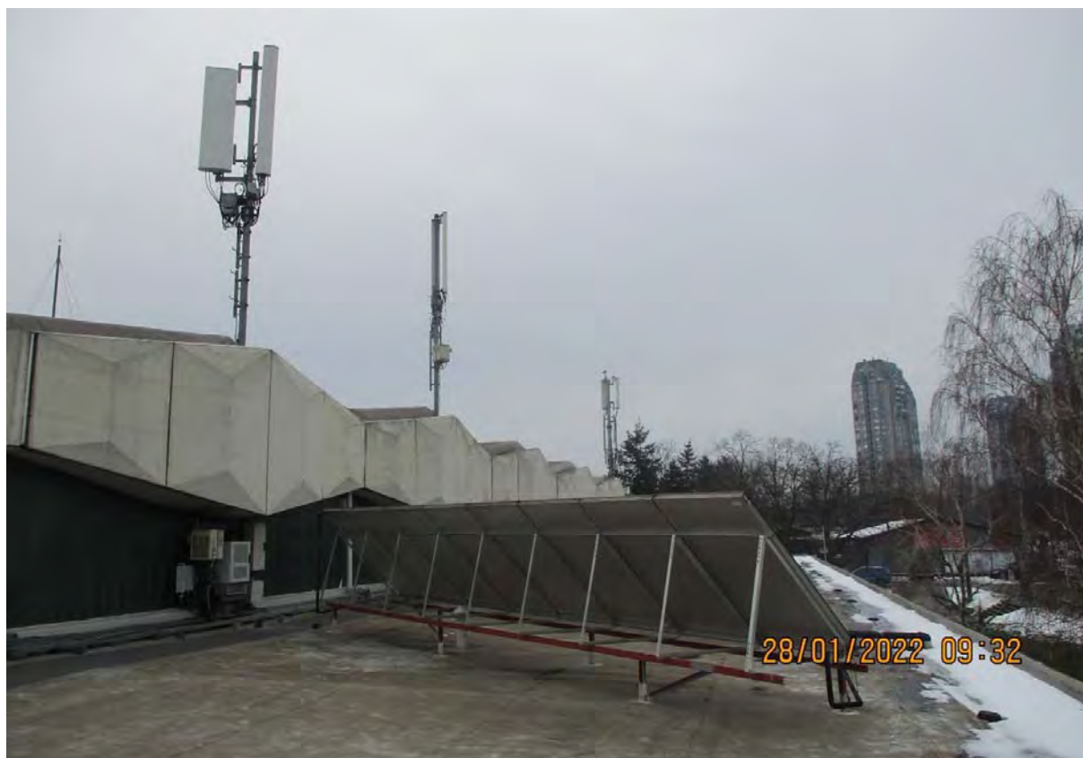
Slika 2.4 Krov objekta na kome se nalazi predmetna BS
