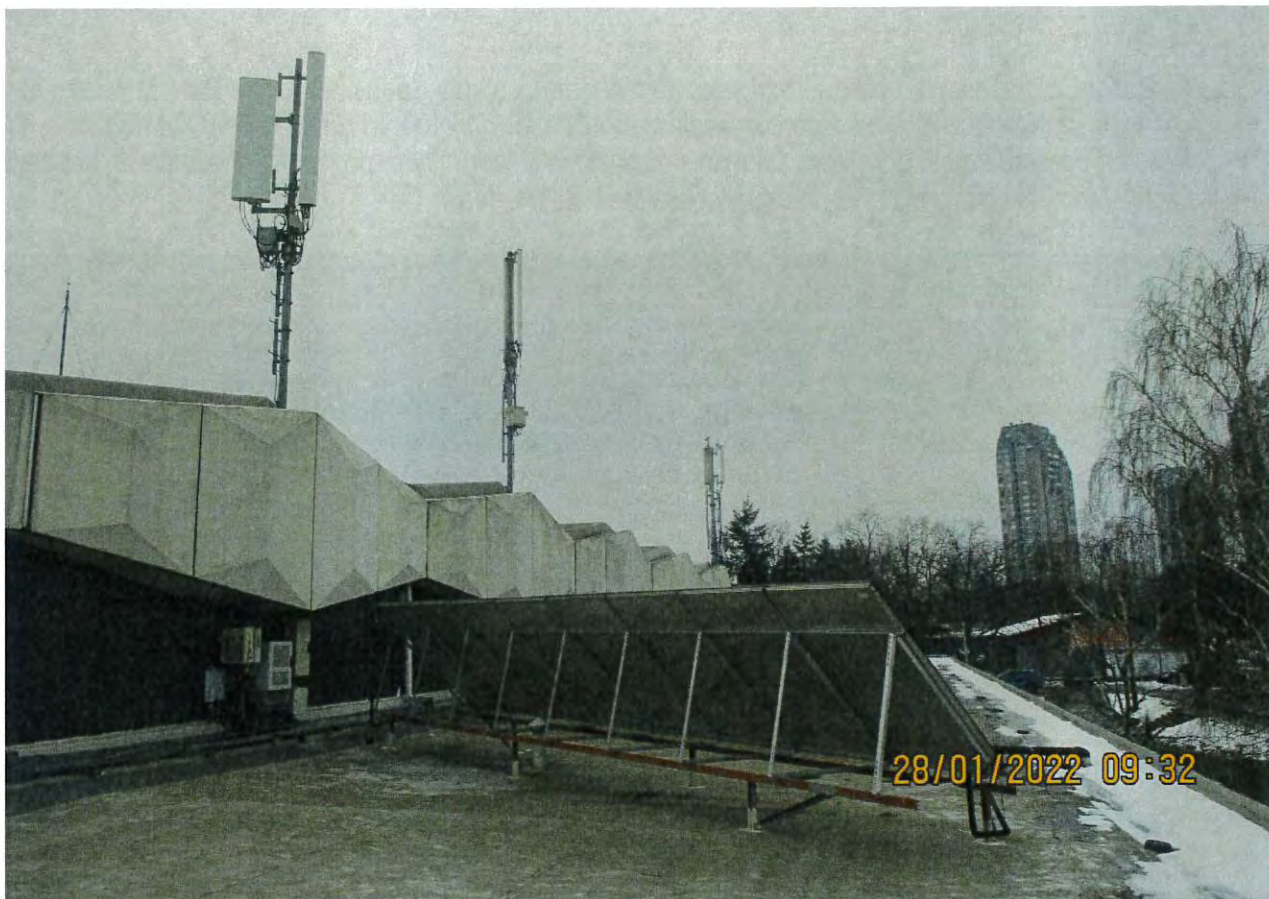
Slika 3: Prikaz krova objekta na kom se nalazi bazna stanica BG_Banjica_Sportski_centar operatora A1 Srbija
