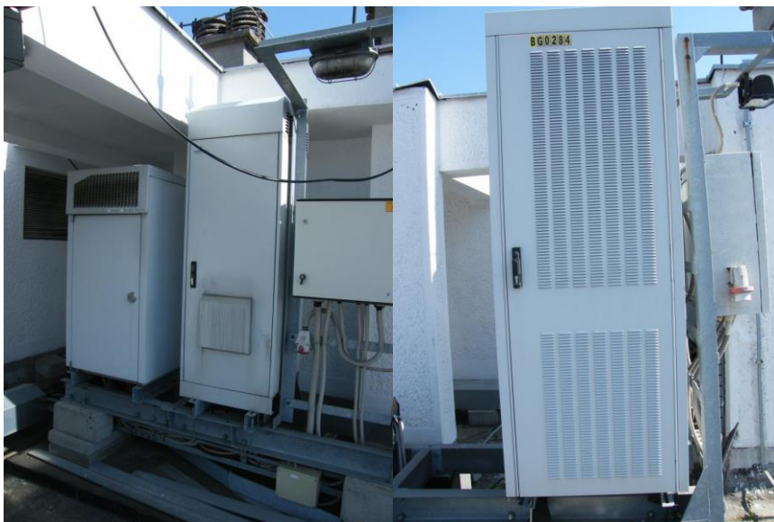
Slika 3.1.3. Fotografija predmetne bazne stanice operatora Telekom Srbija i bazne stanice operatora A1 Srbija
