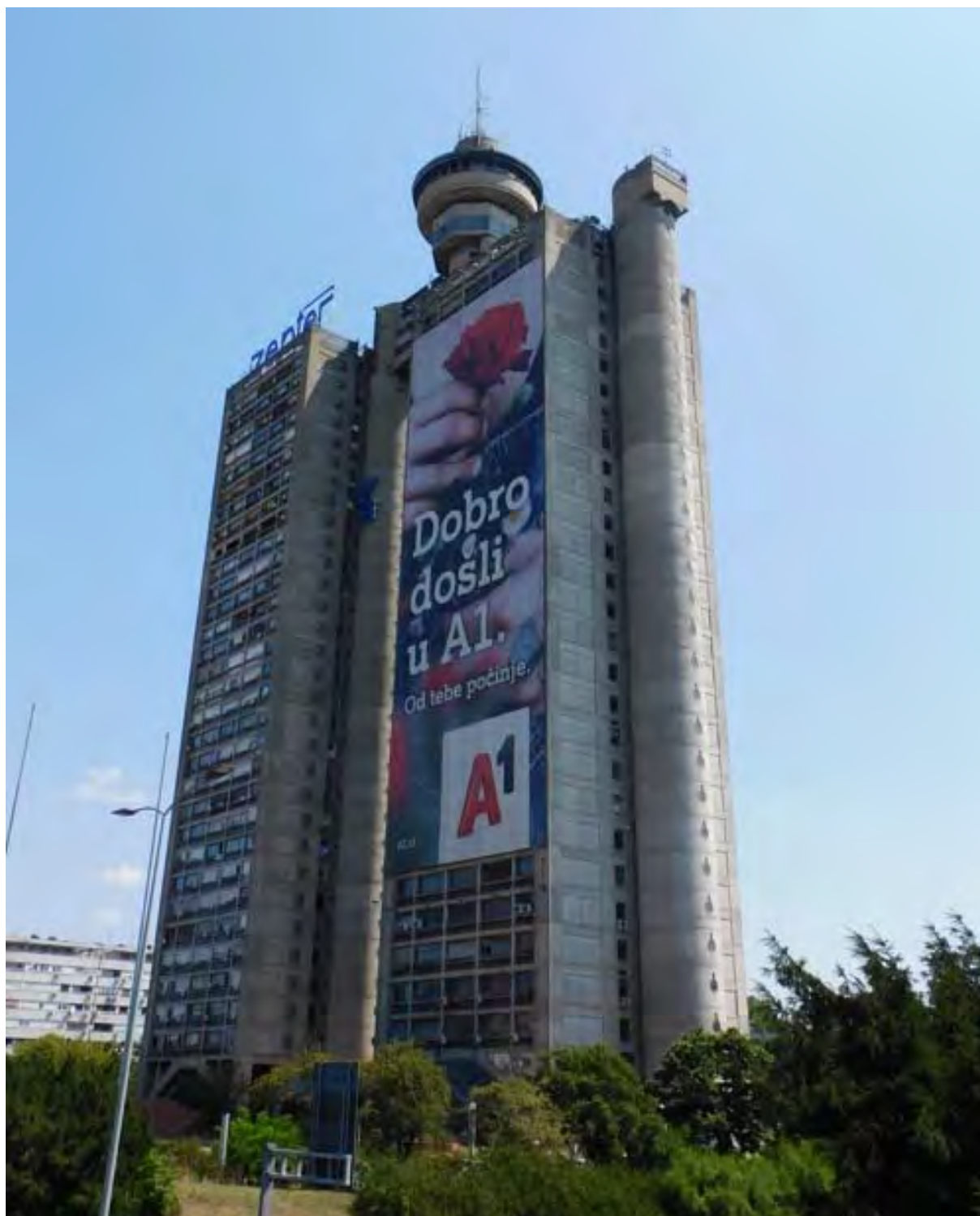
Slika 2.4 Fotografija objekta na kome se nalazi predmetna radio stanica
