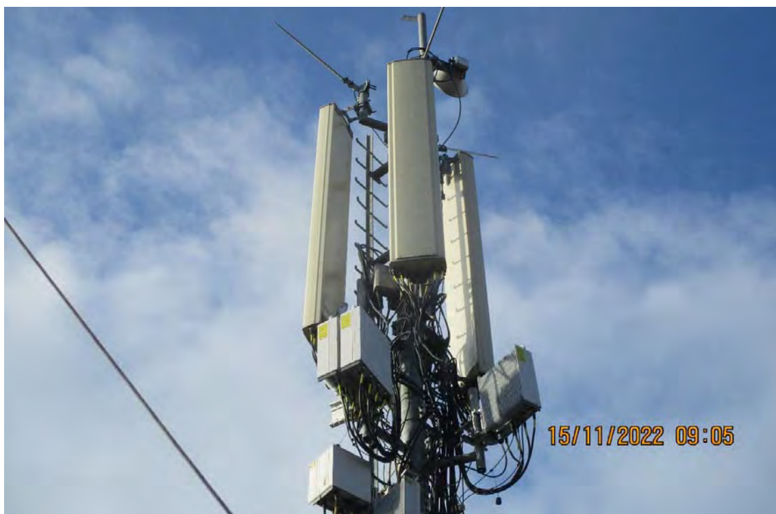
Slika 2.6 Fotografija antenskog sistema sektora 1 predmetne BS
