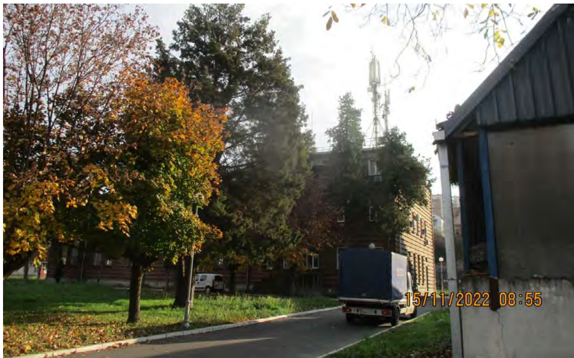
Slika 2.4 Objekat na kome je montirana predmetna BS
