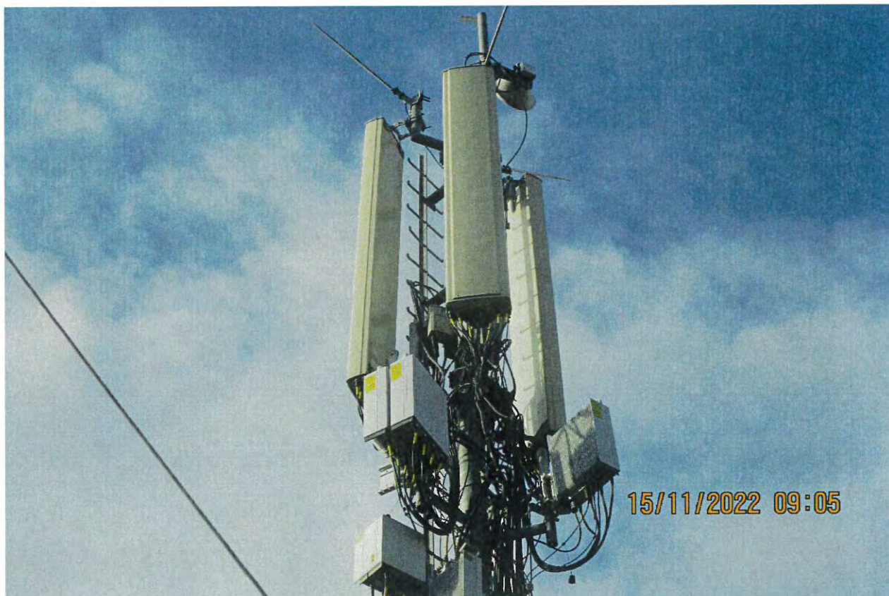
Slika 5 : Prikaz antene i radio modula sektora jedan BS BG-Bele Vode 2 operatora Telekom Srbija
