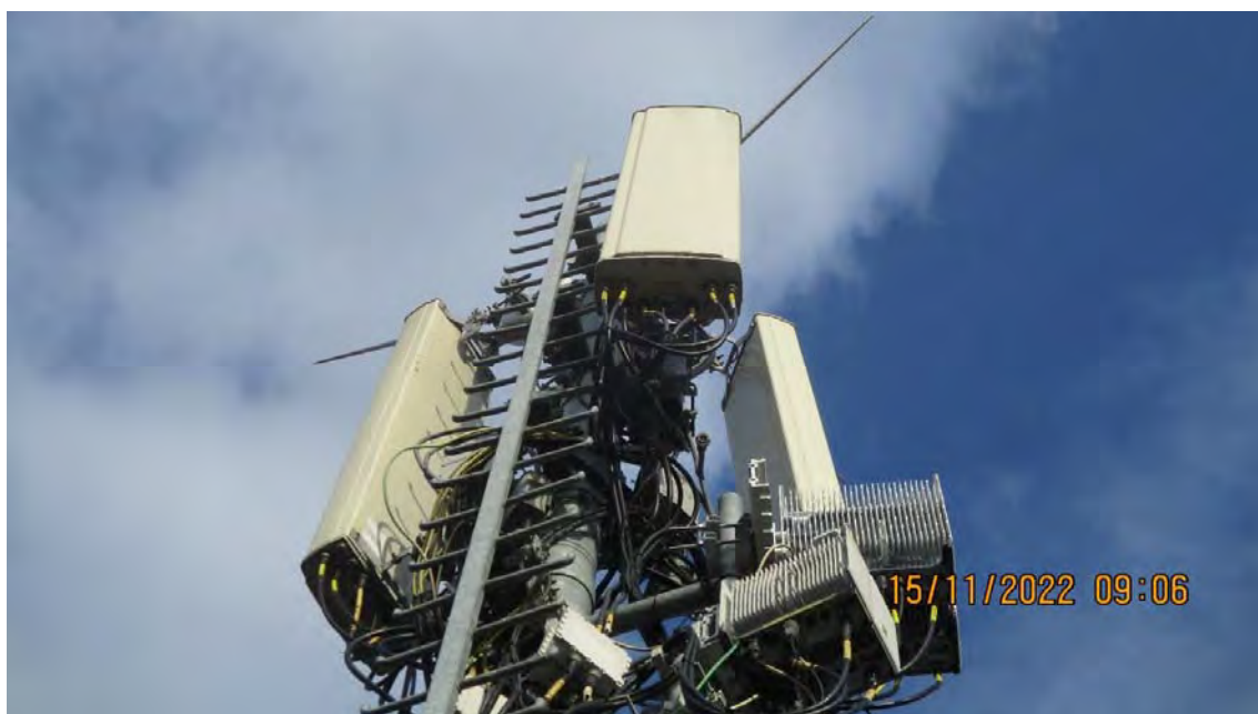
Slika 2.7 Fotografija antenskog sistema sektora 2 predmetne BS
