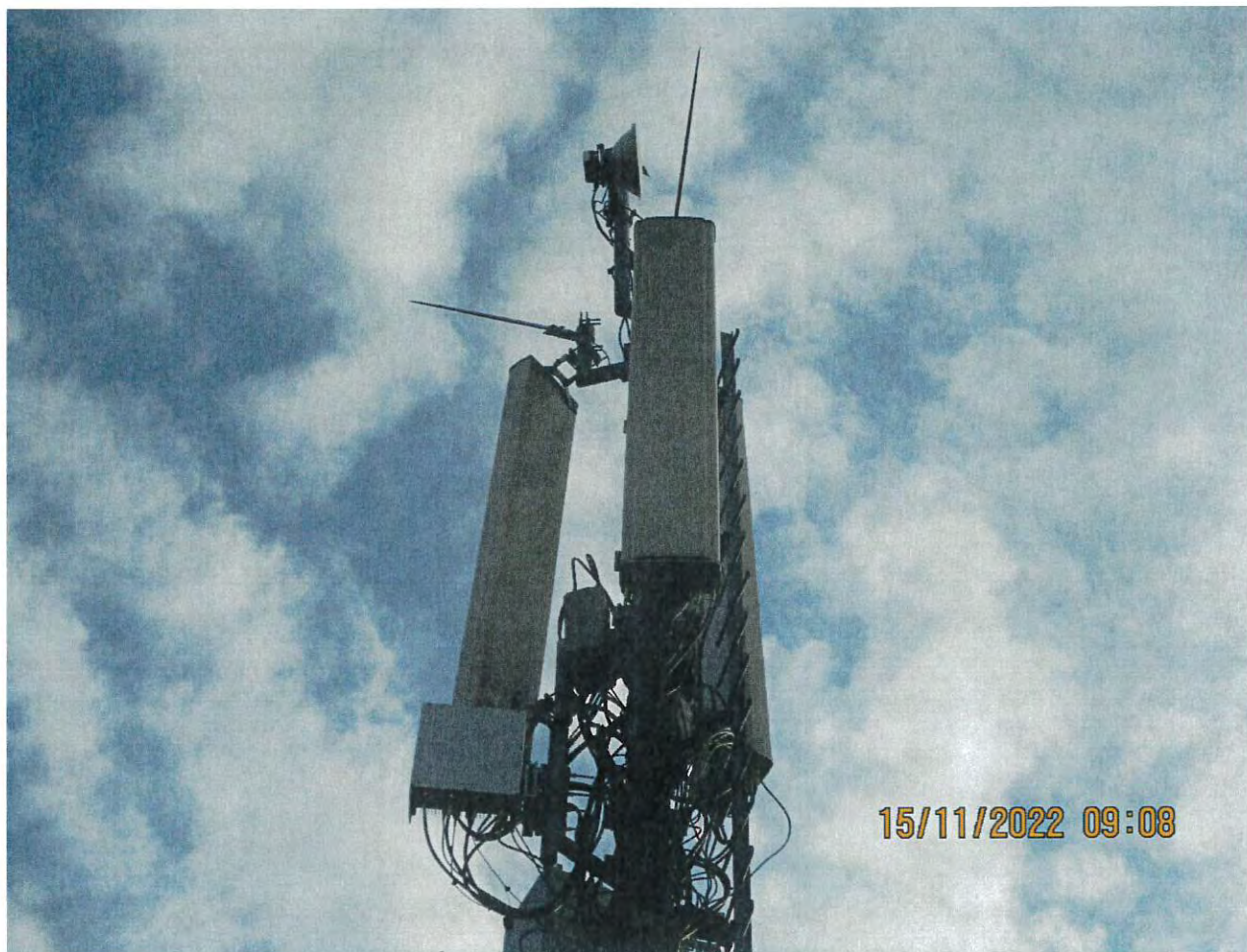
Slika 7 : Prikaz antene i radio modula sektora tri BS BG-Bele Vode 2 operatora Telekom Srbija
