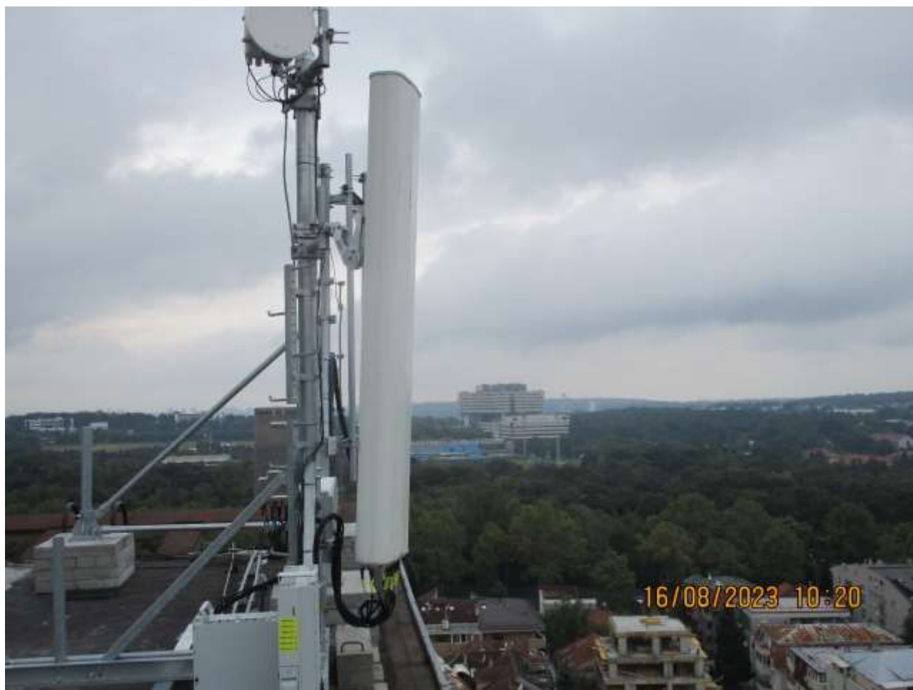
Slika 7: Prikaz antene i radio modula sektora 3
