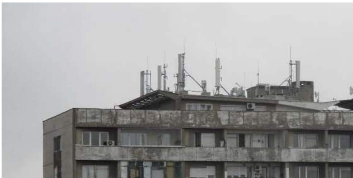
Slika 2.6 Prikaz antenskog sistema predmetne BS
