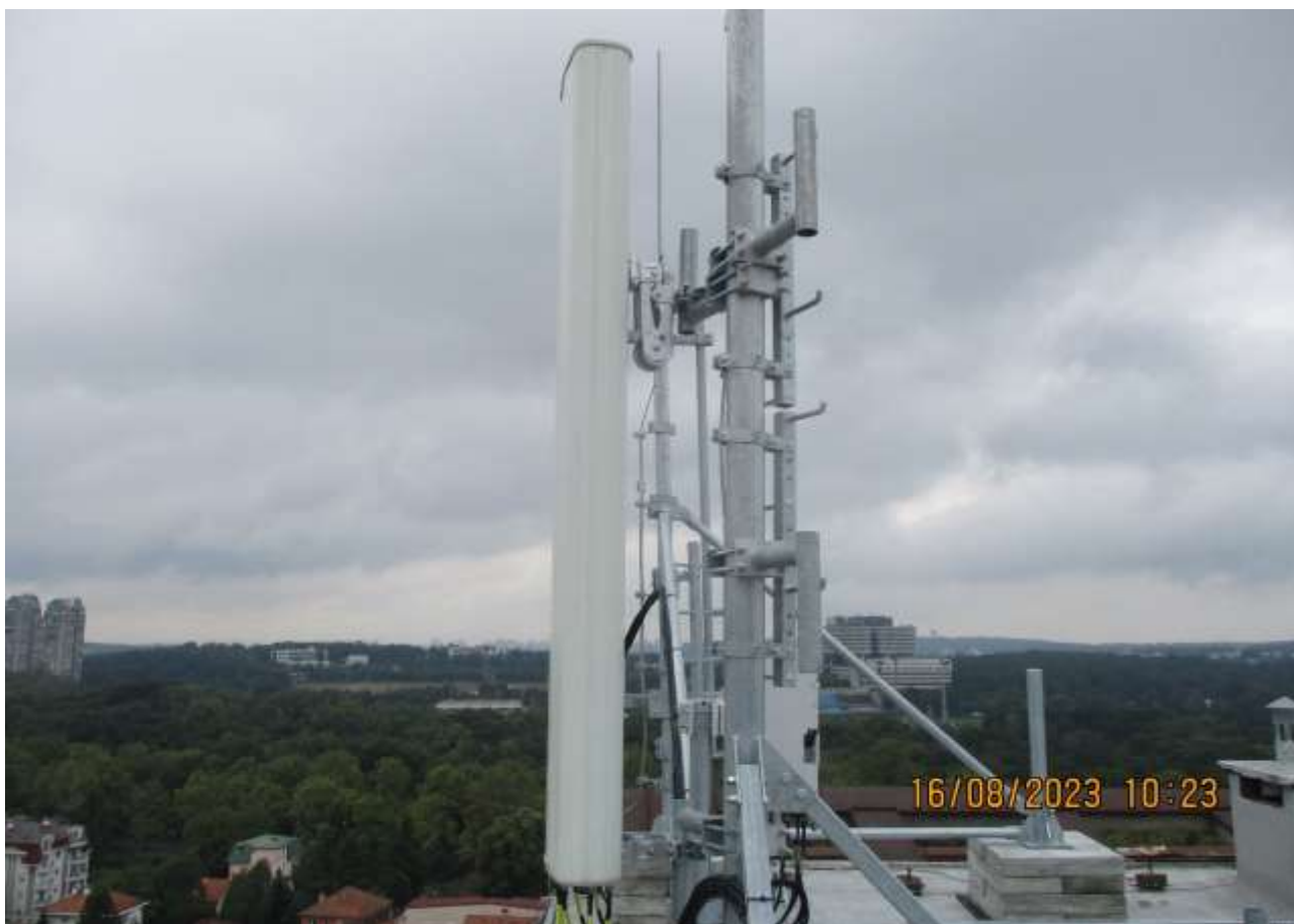
Slika 5: Prikaz antene sektora 1
