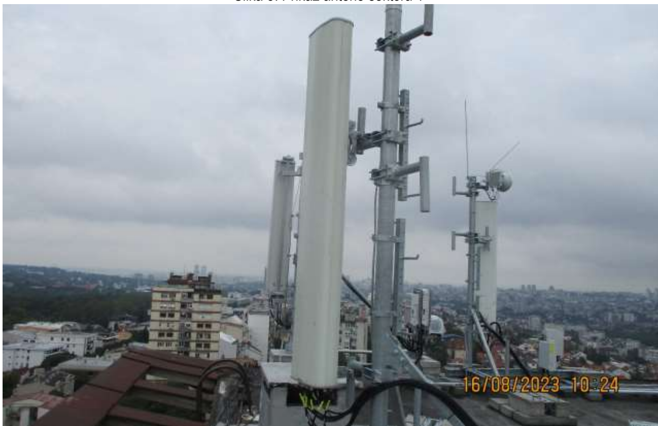
Slika 6: Prikaz antene sektora 2
