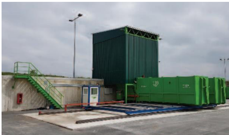
Слика 1. Изграђена аутоматска трансфер станица са колицима за позиционирање роло контејнера и кабином
