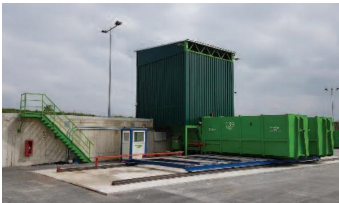
Слика 3-1. Изграђена аутоматска трансфер станица са колицима за позиционирање роло контејнера и кабином
