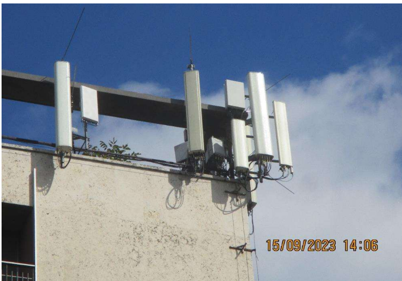
Slika 6 : Prikaz antene i radio modula sektora 3
