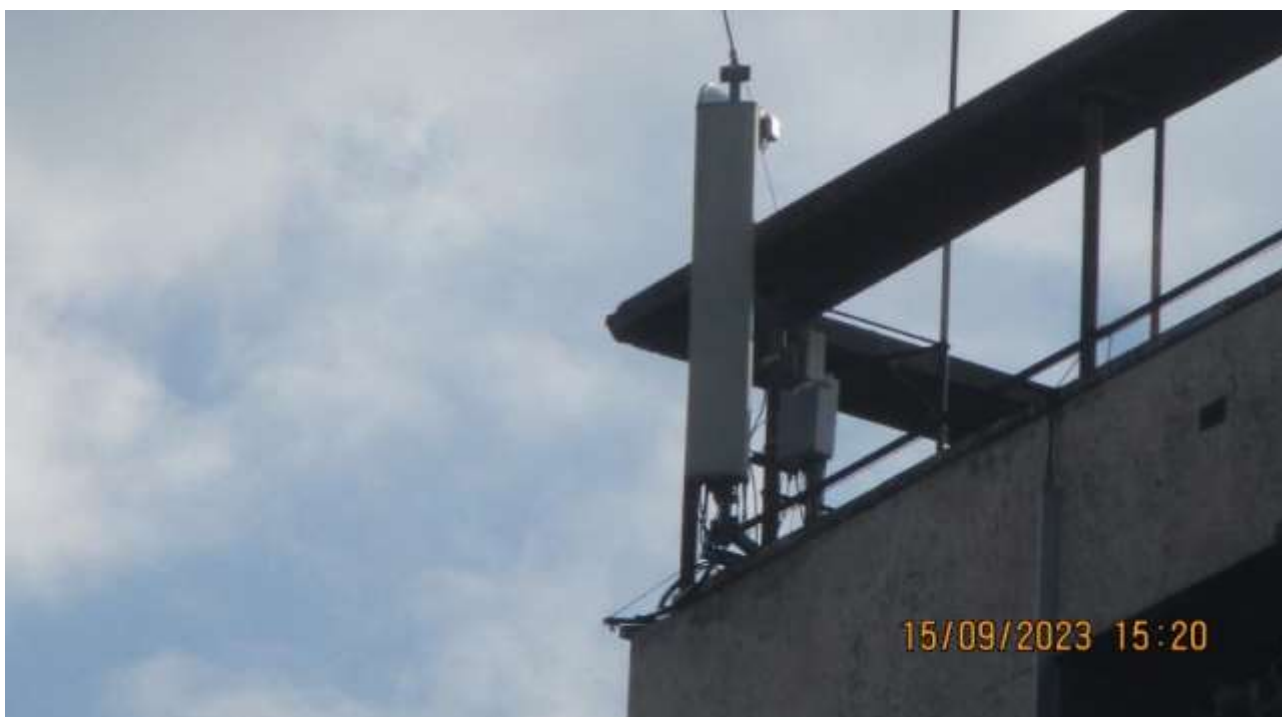
Slika 4 : Prikaz antene i radio modula sektora 1
