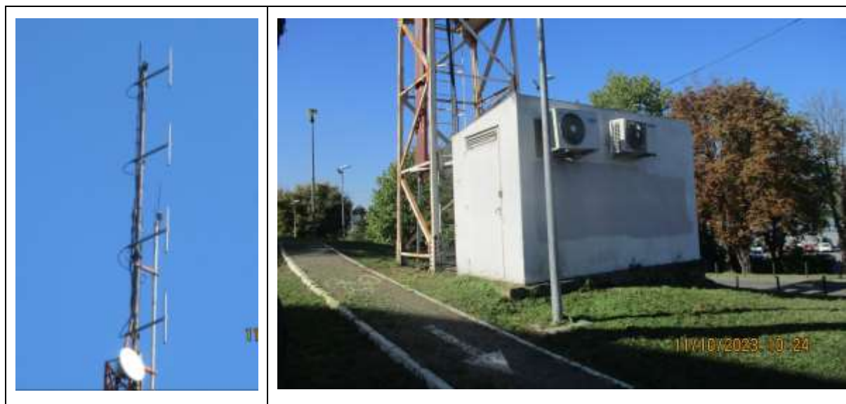
Slika 3.1 Fotografija antenskog sistema i indoor opreme predmetne FM radio stanice
