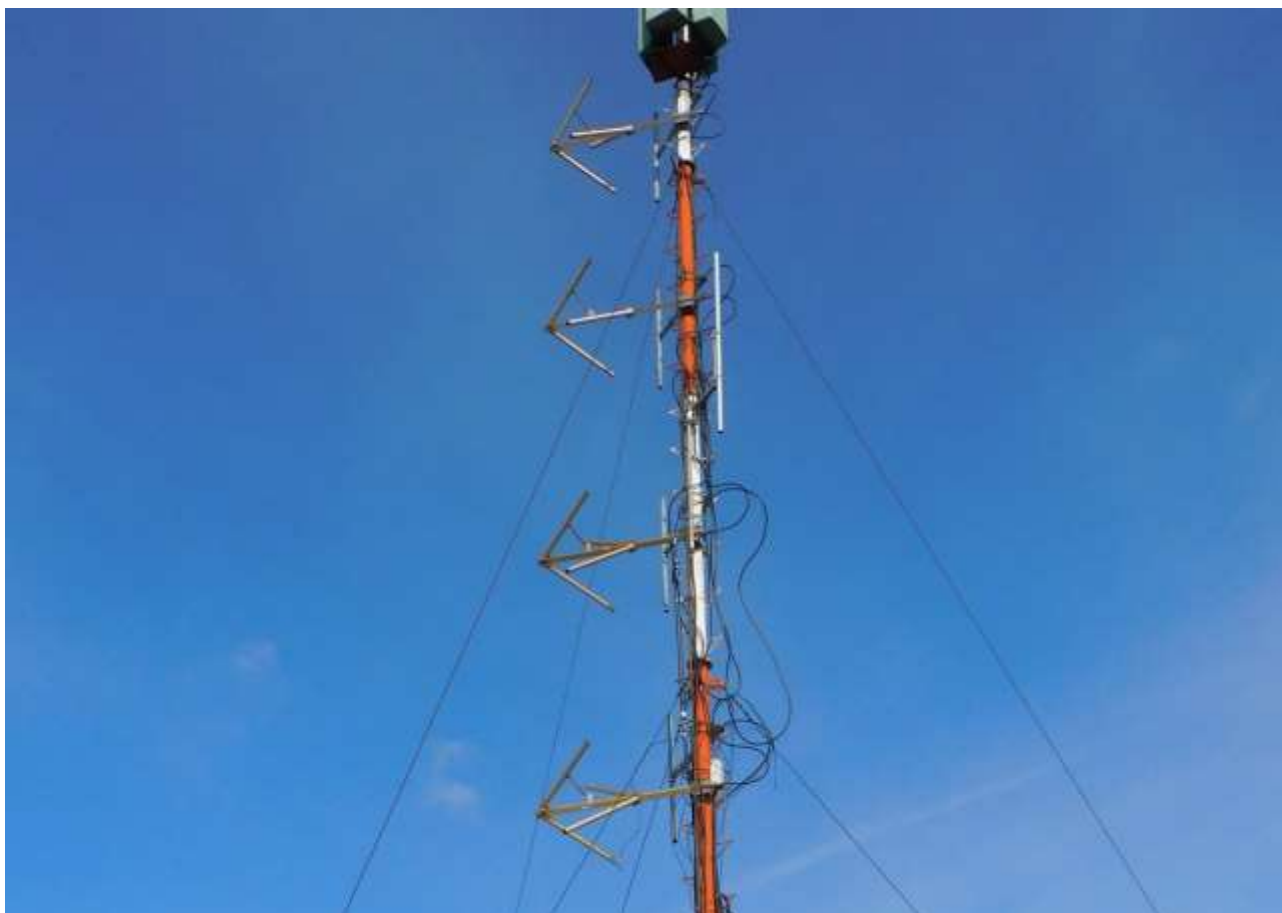
Slika 4: Prikaz antenskog sistema FM radio stanice Radio S4 102.2
