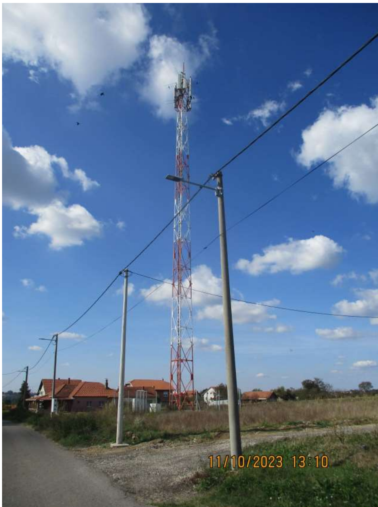
Slika 3: Prikaz antenskog stuba na kom se nalazi antenski sistem bazne stanice
