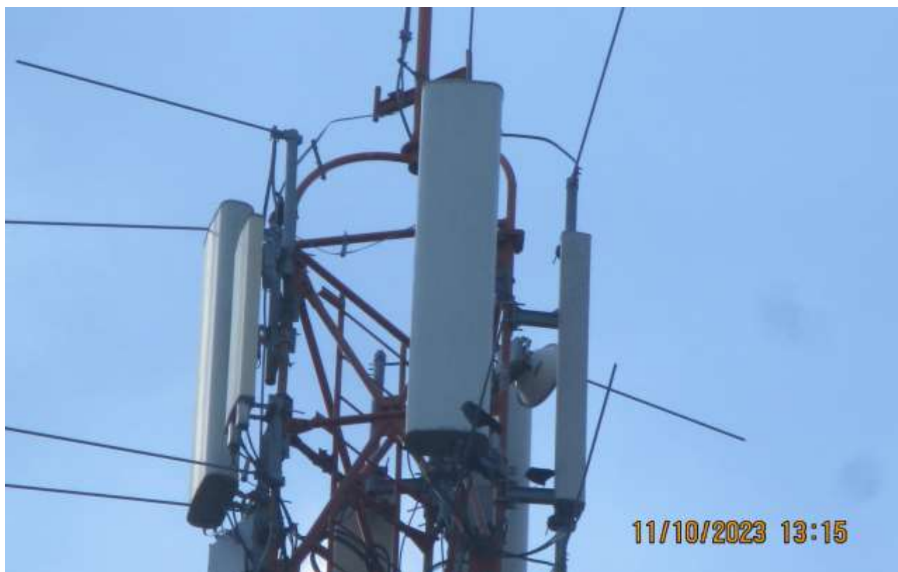
Slika 4 : Prikaz antena i radio modula sektora 1
