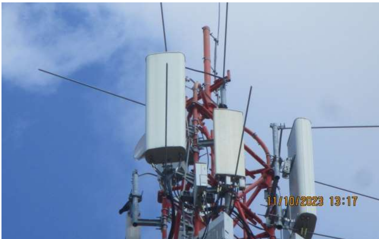
Slika 6 : Prikaz antena i radio modula sektora 3
