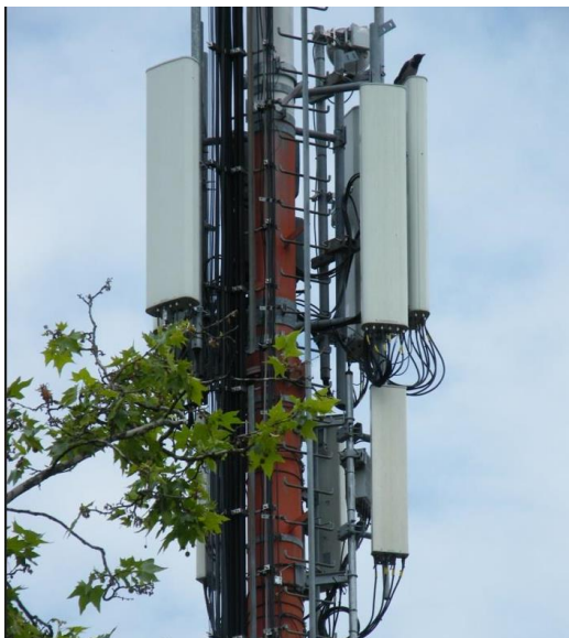
Slika 3.1.3. Fotografija antenskog sistema operatora MUP Srbija, Yettel i A1 Srbija
