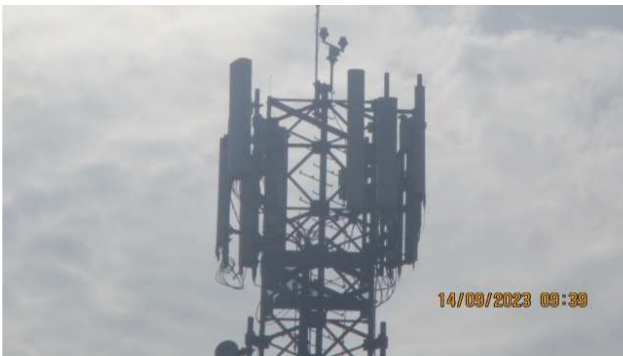
Slika 7 : Prikaz antena i radio modula sektora 4
