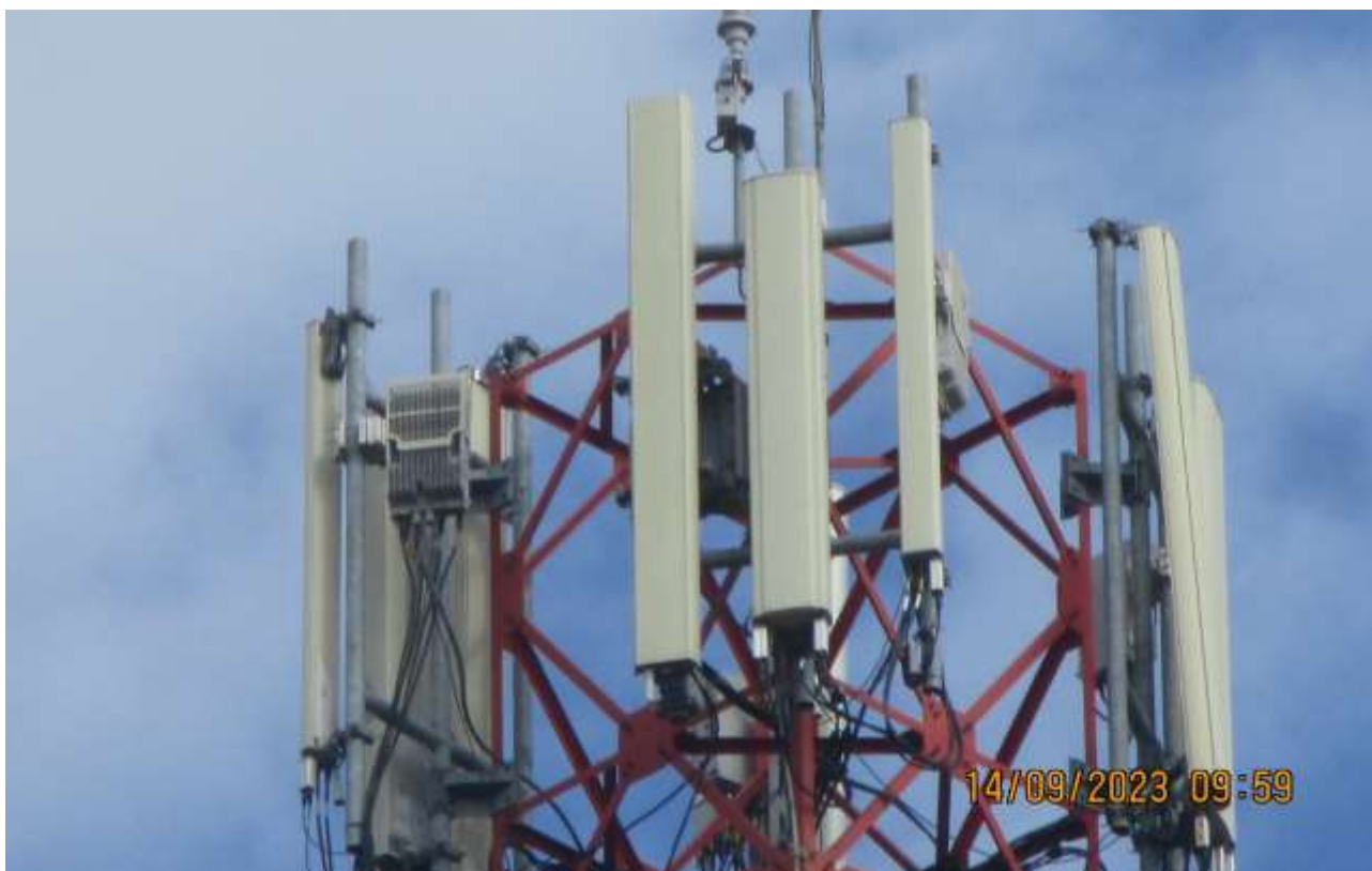
Slika 6 : Prikaz antena i radio modula sektora 3
