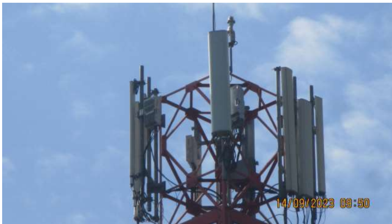
Slika 4 : Prikaz antene i radio modula sektora 1
