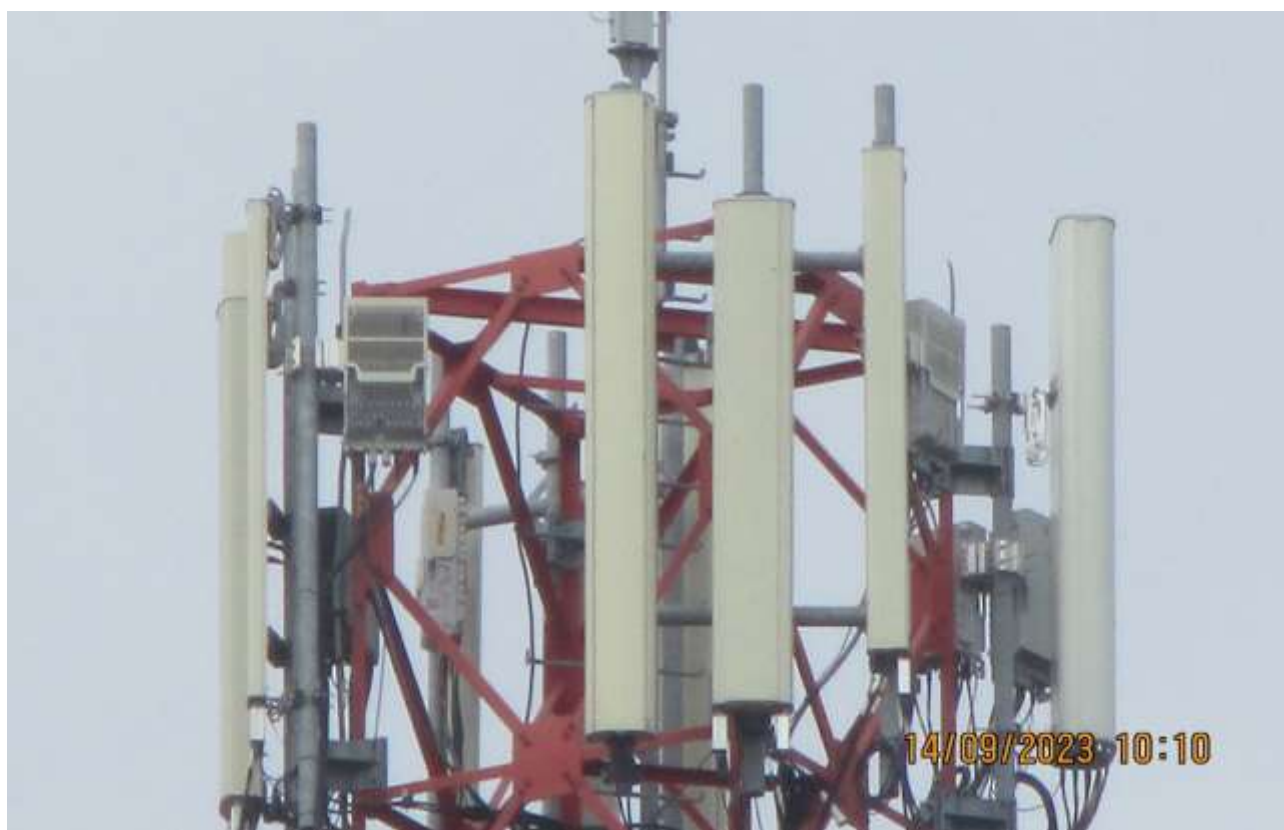
Slika 5 : Prikaz antena i radio modula sektora 2
