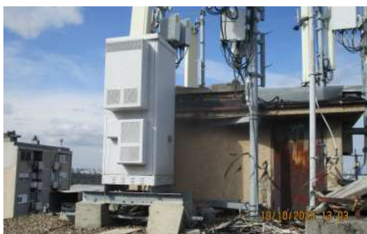
Slika 2.5 Kabineti predmetne Telekom BS na krovu objekta
