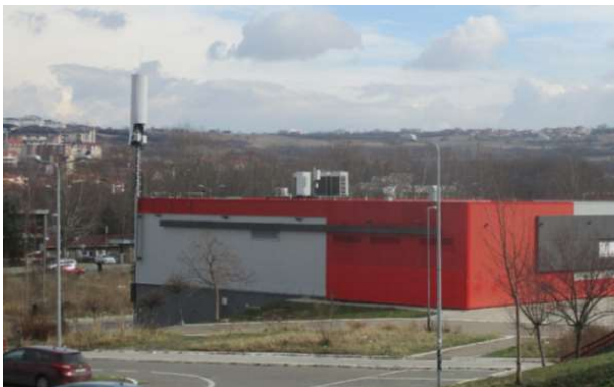
Slika 2.4 Objekat na kome je montirana predmetna BS
