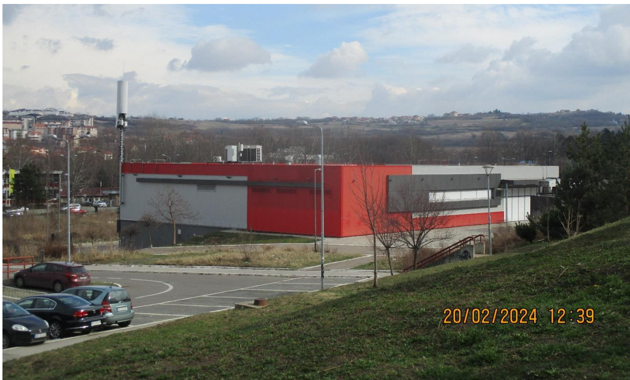
Slika 3: Prikaz objekta na kom se nalazi bazna stanica
