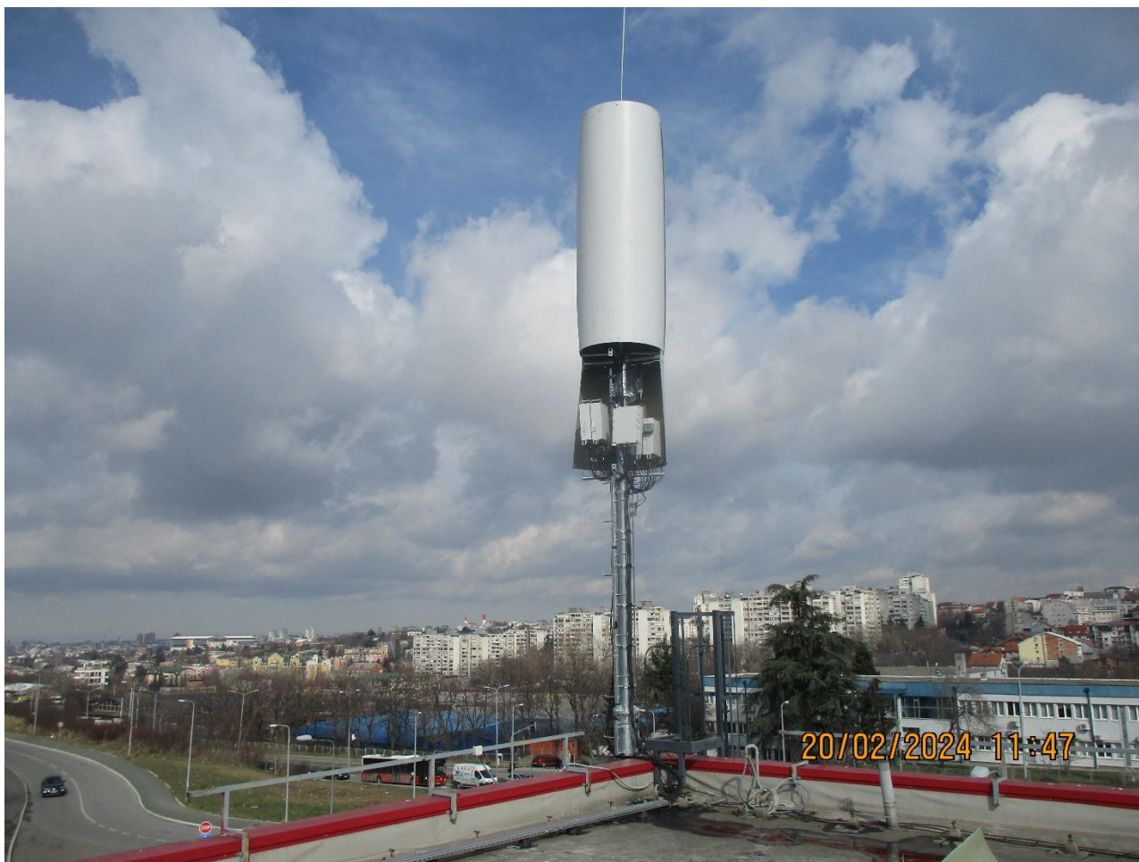
Slika 5: Prikaz antenskog sistema bazne stanice
