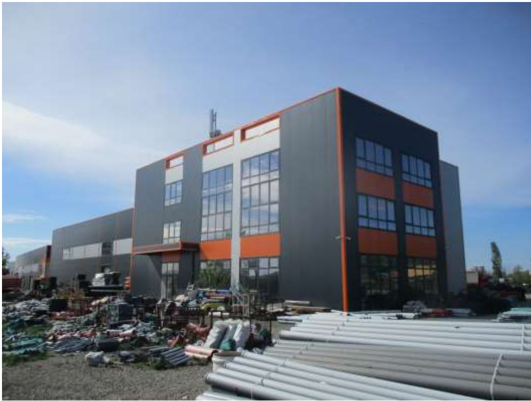
Slika 2.4 Objekat na kom će se montirati bazna stanica
