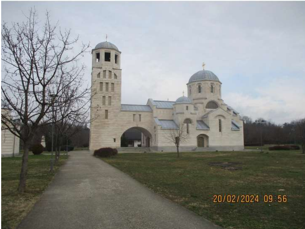
Slika 2.4 Prikaz objekta na kom se planira montaža nove A1 Srbija bazne stanice
