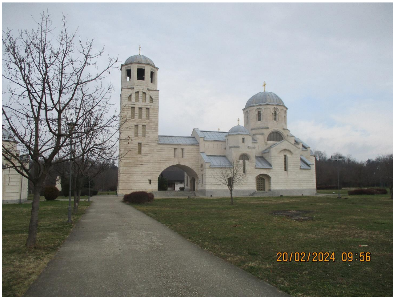
Slika 3: Prikaz objekta na kom se planira montaža nove A1 Srbija bazne stanice
