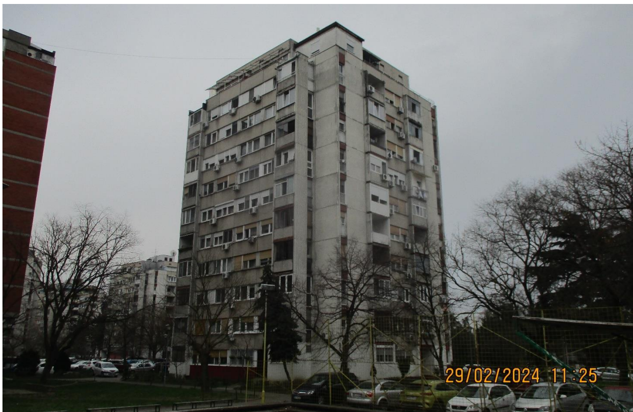
Slika 3: Prikaz objekta na kom se nalazi bazna stanica
