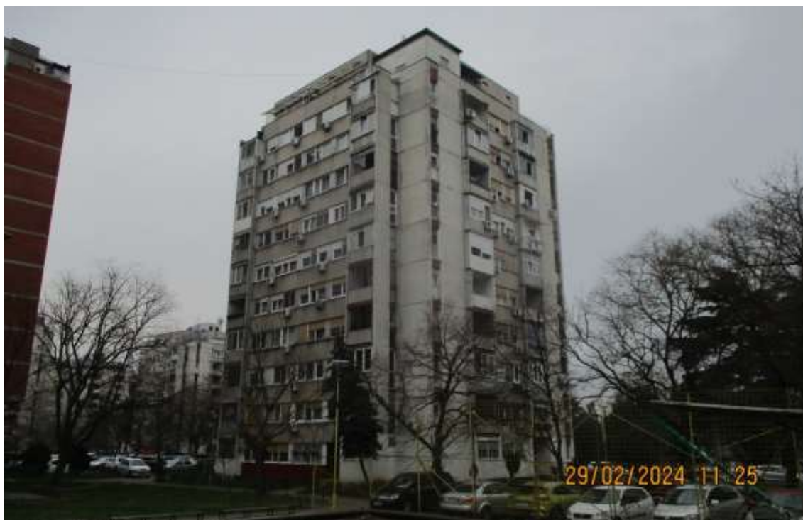
Slika 2.4 Objekat na kom je montirana predmetna bazna stanica
