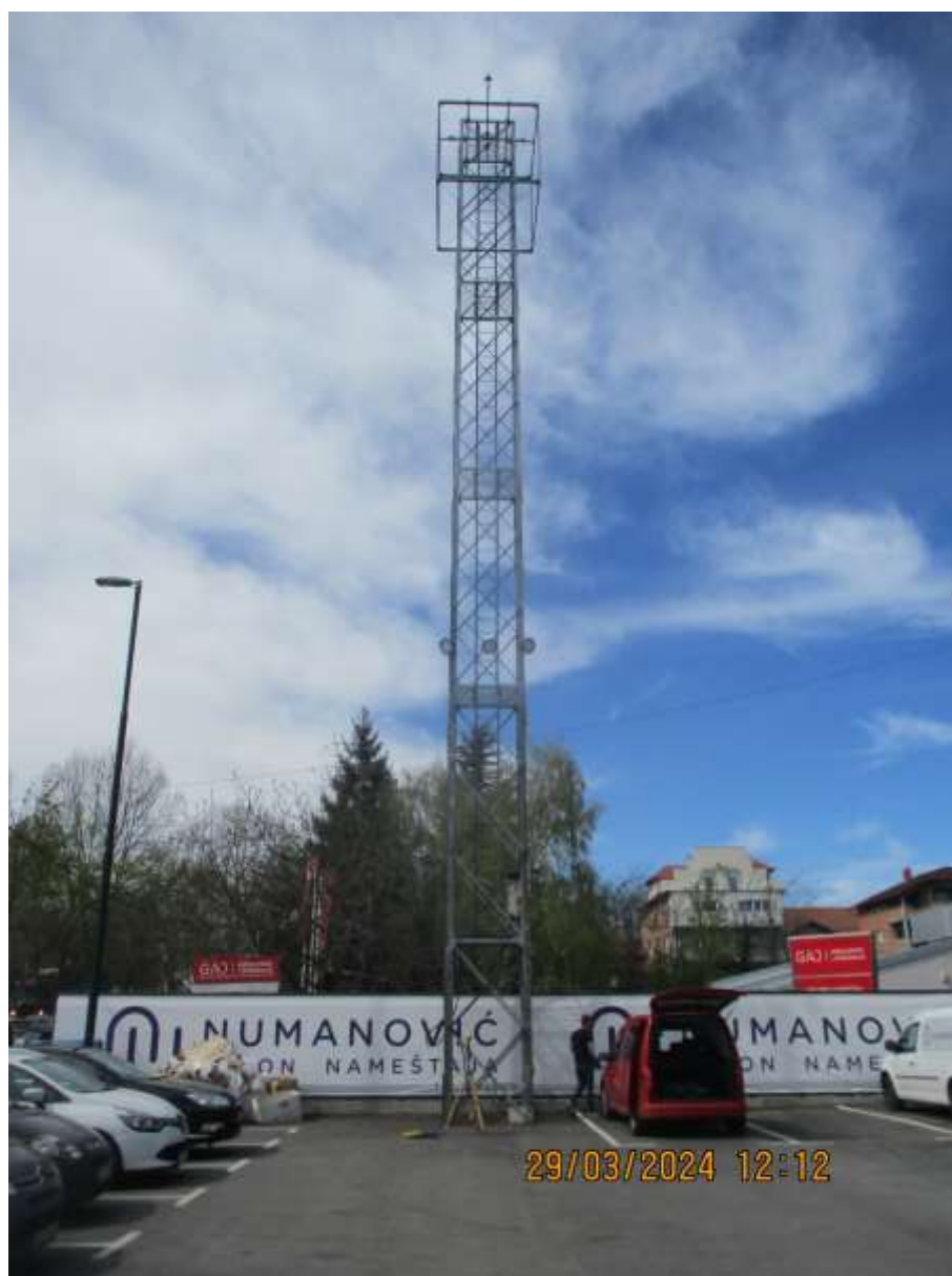
Slika 2.4 Objekat na kome se planira montaža predmetne BS
