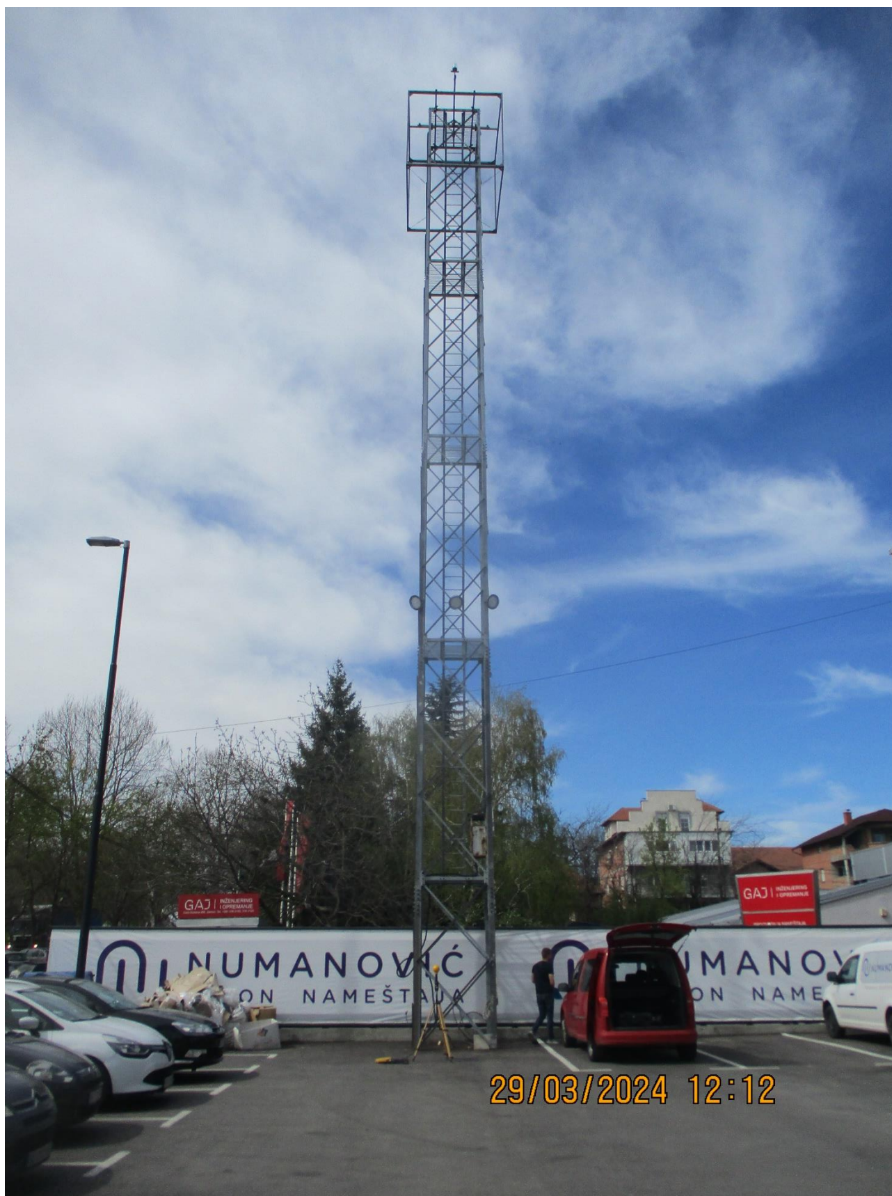
Slika 3: Prikaz stuba na kom se planira montaža Telekom Srbija bazne stanice Zemun-Cara Dušana
