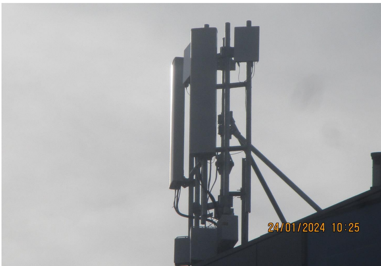
Slika 4 : Prikaz antene sektora 1
