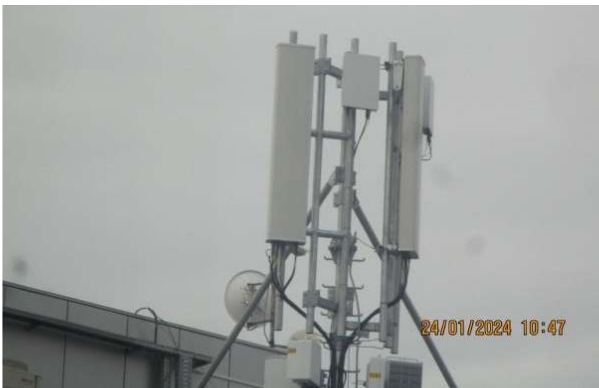
Slika 2.7 Antenski sistem predmetne BS – sektor 2
