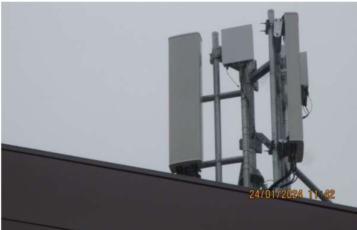
Slika 2.9 Antenski sistem predmetne BS – sektor 4
