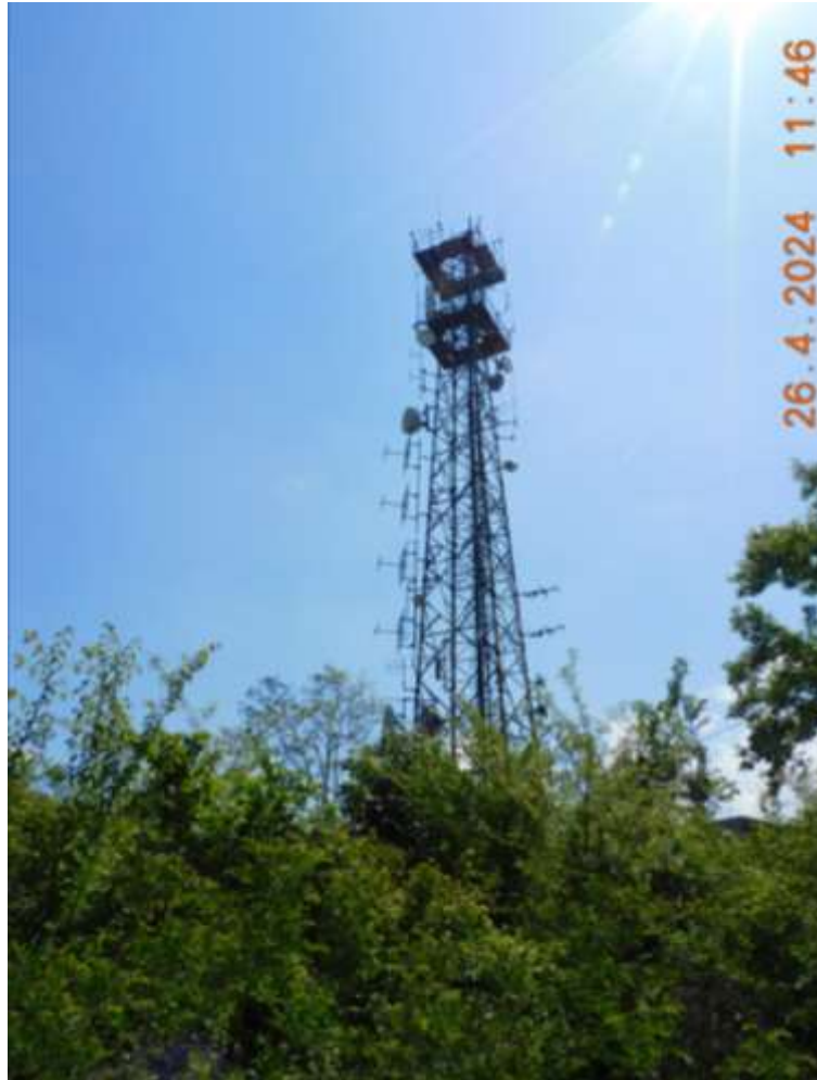
Slika 2.3 Prikaz lokacije na kojoj se nalazi predmetna radio stanica
