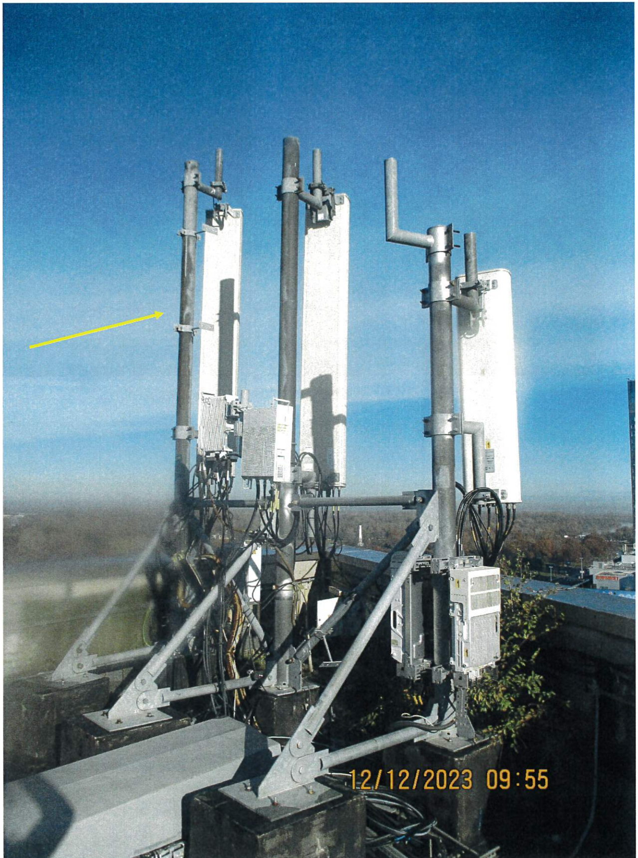
Slika 5: Prikaz antene i radio modula sektora 1
