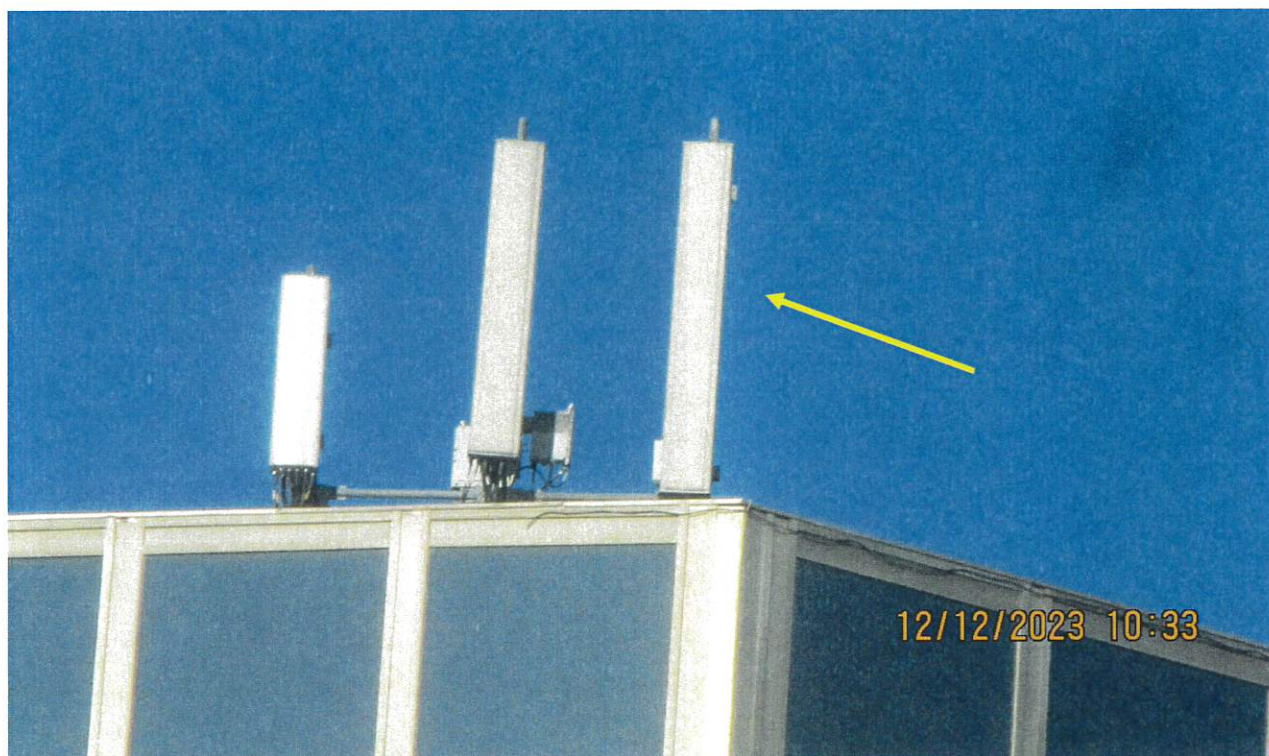
Slika 6: Prikaz antene i radio modula sektora 2
