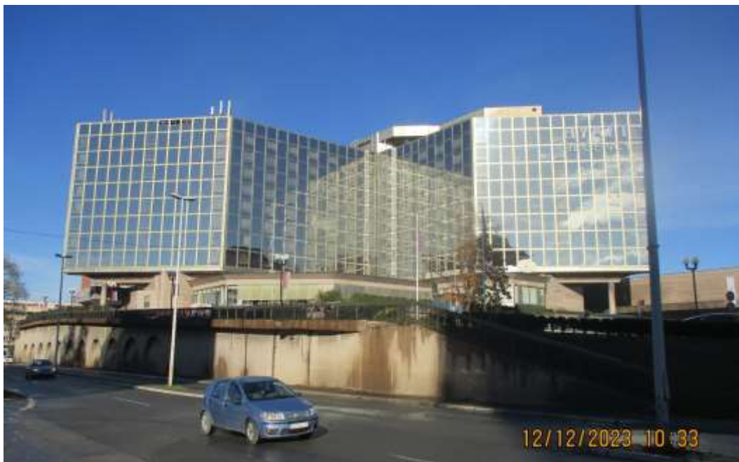
Slika 2.4 Objekat na kome se planira montaža predmetne BS
