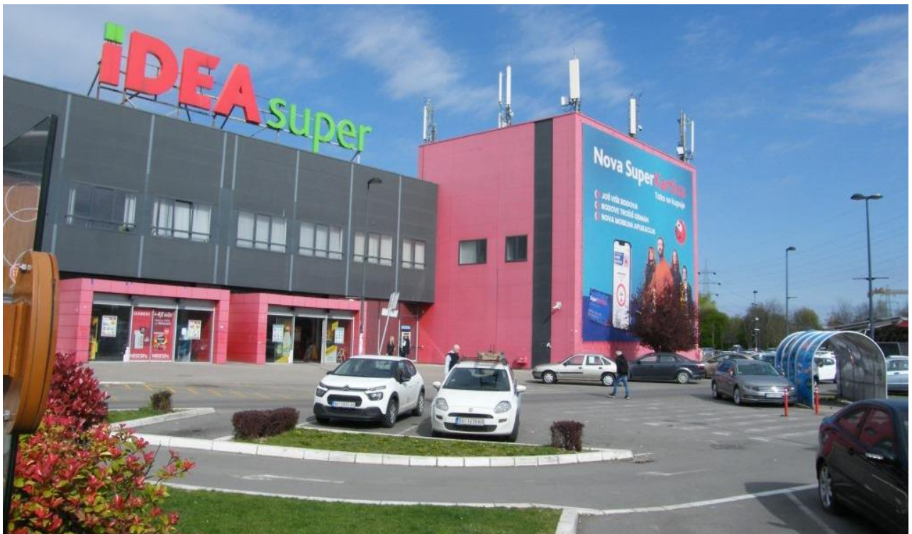
Slika 2.2 Izgled objekta na kom je bazna stanica
