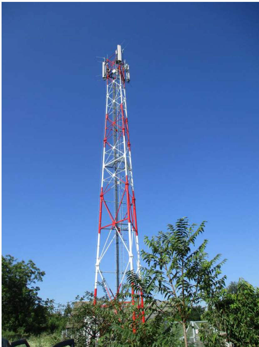
Slika 2.2 Izgled lokacije na kojoj se nalazi instalacija bazne stanice «BG0769_02 BG_Popovic»
