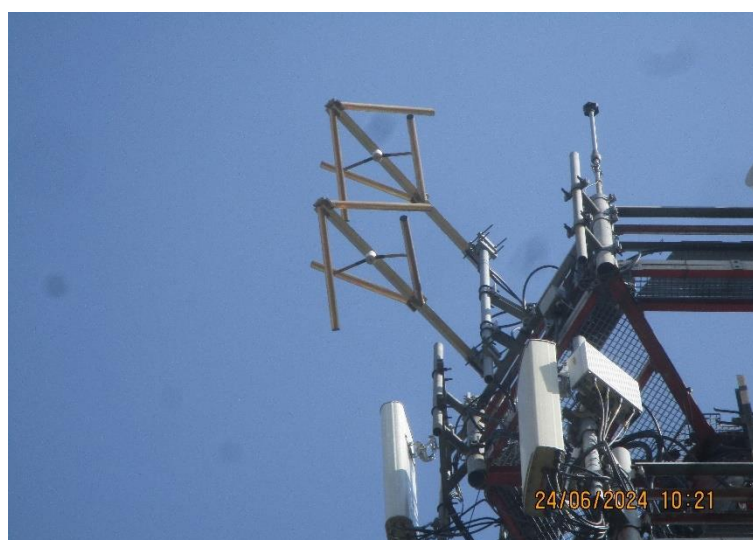
Slika 4: Prikaz antenskog sistema FM radio stanice Radio Lola 106.3
