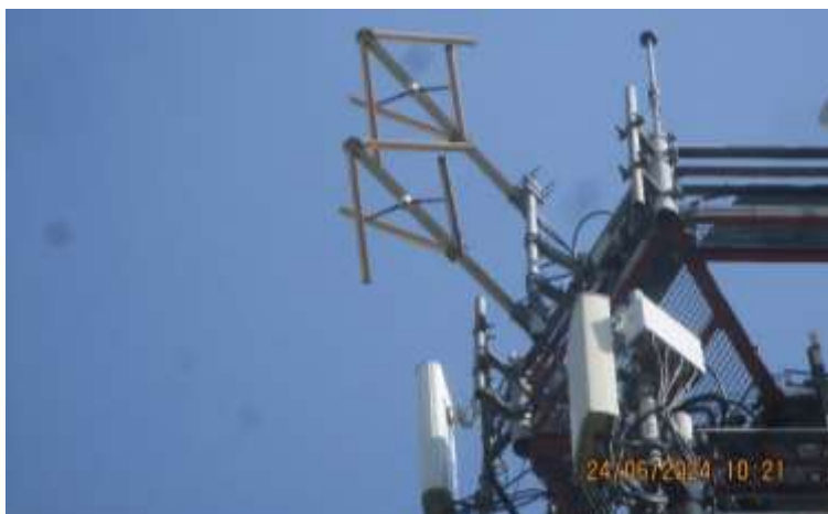
Slika 2.4 Prikaz antenskog sistema Radio Lola 106.3
