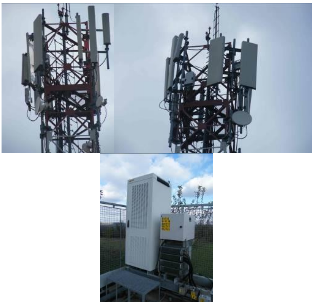
Slika 2.3. Fotografije antenskog sistema i kabineta predmetne bazne stanice operatera Telekom Srbija
